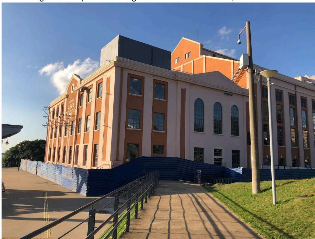
Figura 25: Tapumes ao longo da Usina do Gasômetro, abril de 2025.
