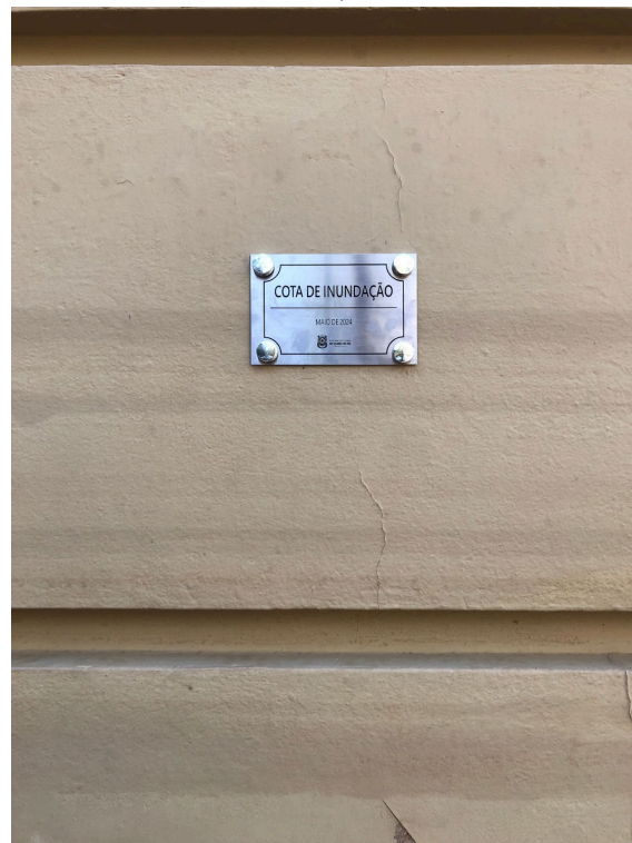
Figura 24: Placa de cota de inundação na fachada do MARGS, outubro de 2024.
