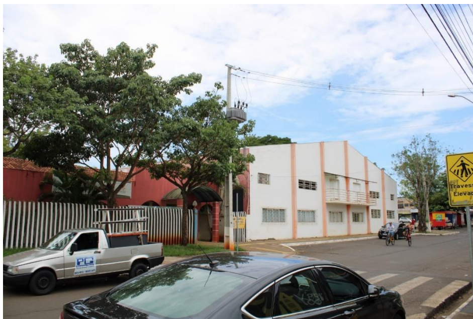
Fig. 10 “Centro de Convivência dos idosos Afra Roth”– Foz do Iguaçu, fotografia tomada ángulo izquierdo (archivo personal)
