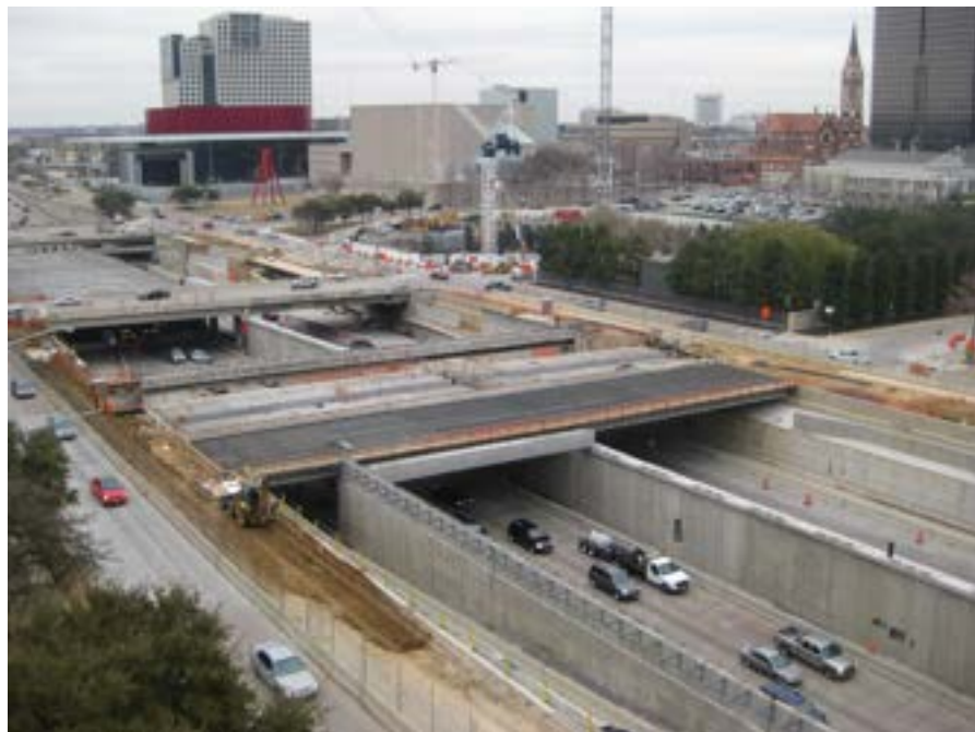
Figura 45: Preenchimento entre as vigas de sustentação, FONTE: Woodall Rodgers Freewa
