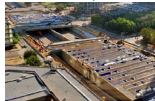
Figura 46: Vigas de sustentação, FONTE: Woodall Rodgers Freewa
