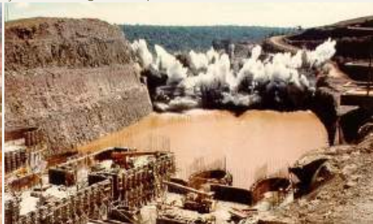
Figura 14 e 15: Construção da barragem e explosão de ensecadeiras
