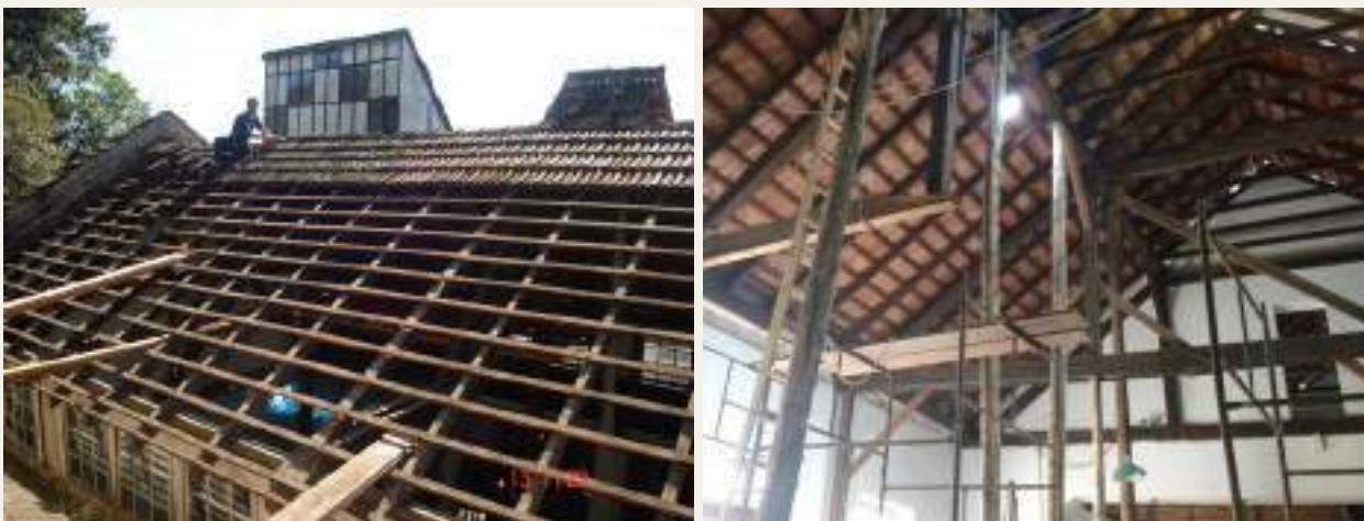
Figuras 23 e 24: Manutenção e reforma na estrutura do telhado do museu durante a intervenção
