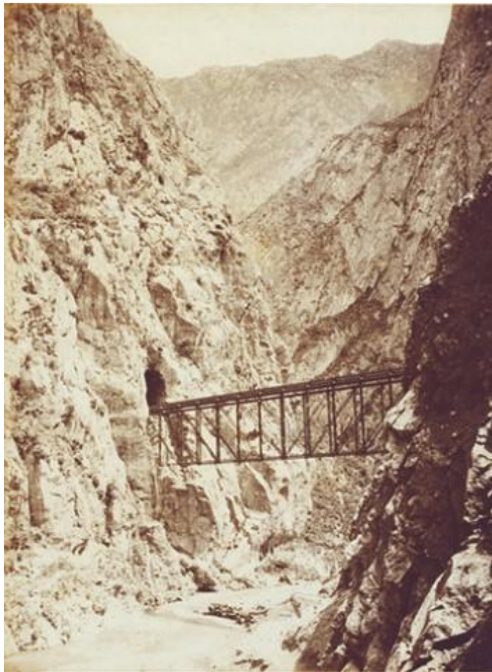
Fotografía 6: Ferrocarril Central. Viaducto de Infiernillo, c. 1875.
