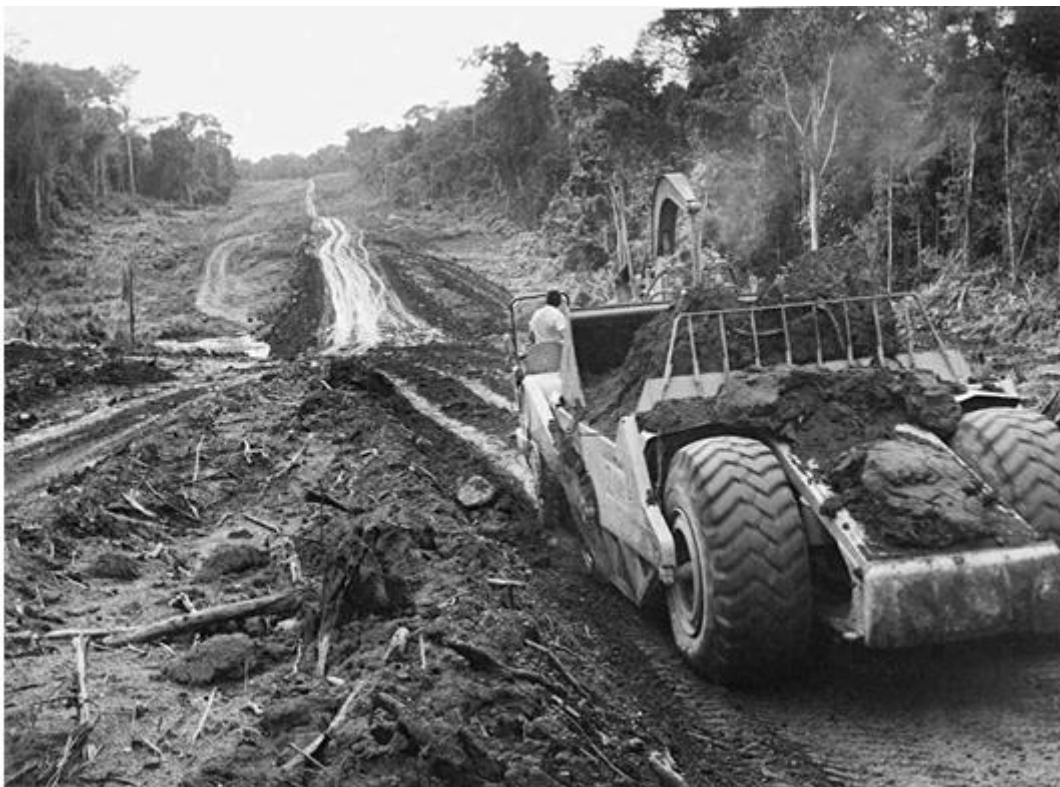
Figura 1 - Trator faz terraplenagem durante a construção da segunda etapa da rodovia Transamazônica, em 1972
