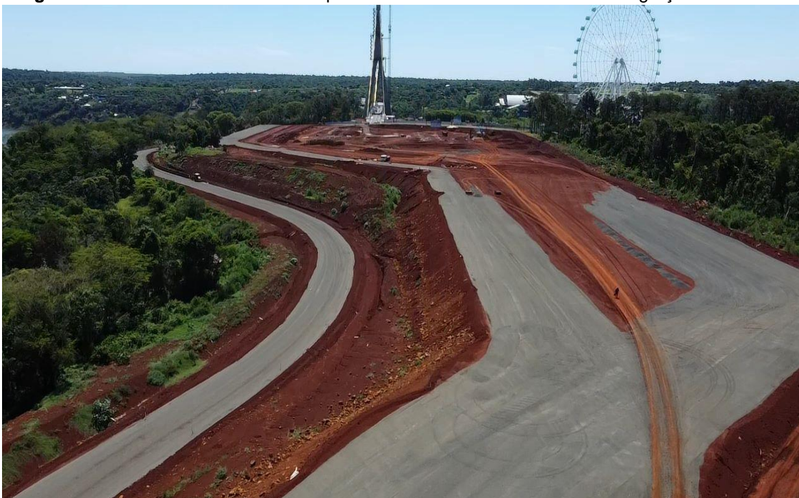
Imagem 06: Obras da Perimetral Leste próximas à Ponte Internacional da Integração.
