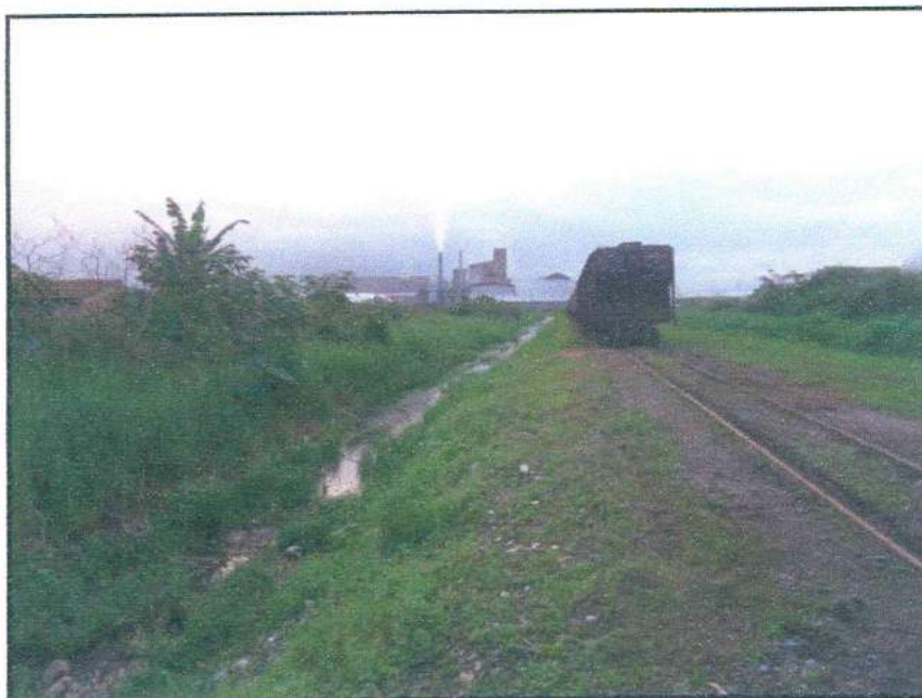
Figura 6 . - Foto de um canal de drenagem marginal do setor de terminais granéis líquidos e terminais de fertilizantes (fonte do autor)
