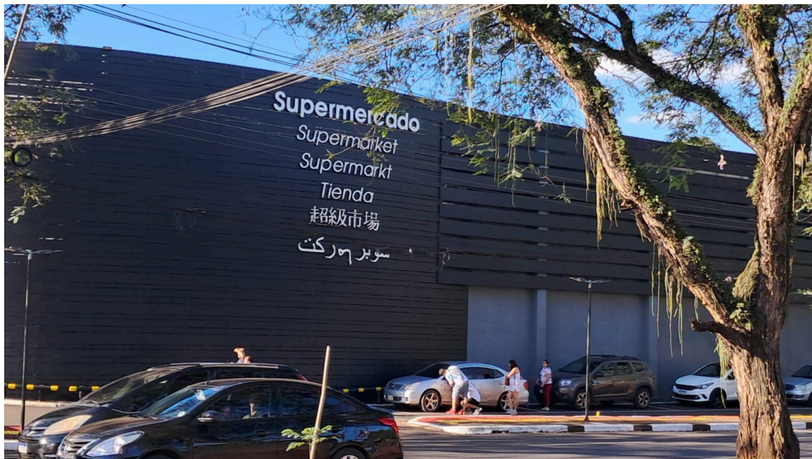
Figura 5 – Fachada do supermercado
