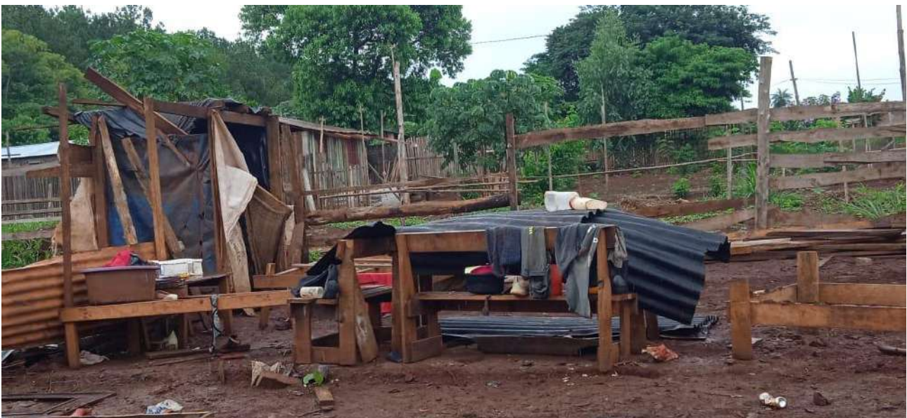
Fotografía 2 – Baño de una vivienda ubicada en el barrio San José
