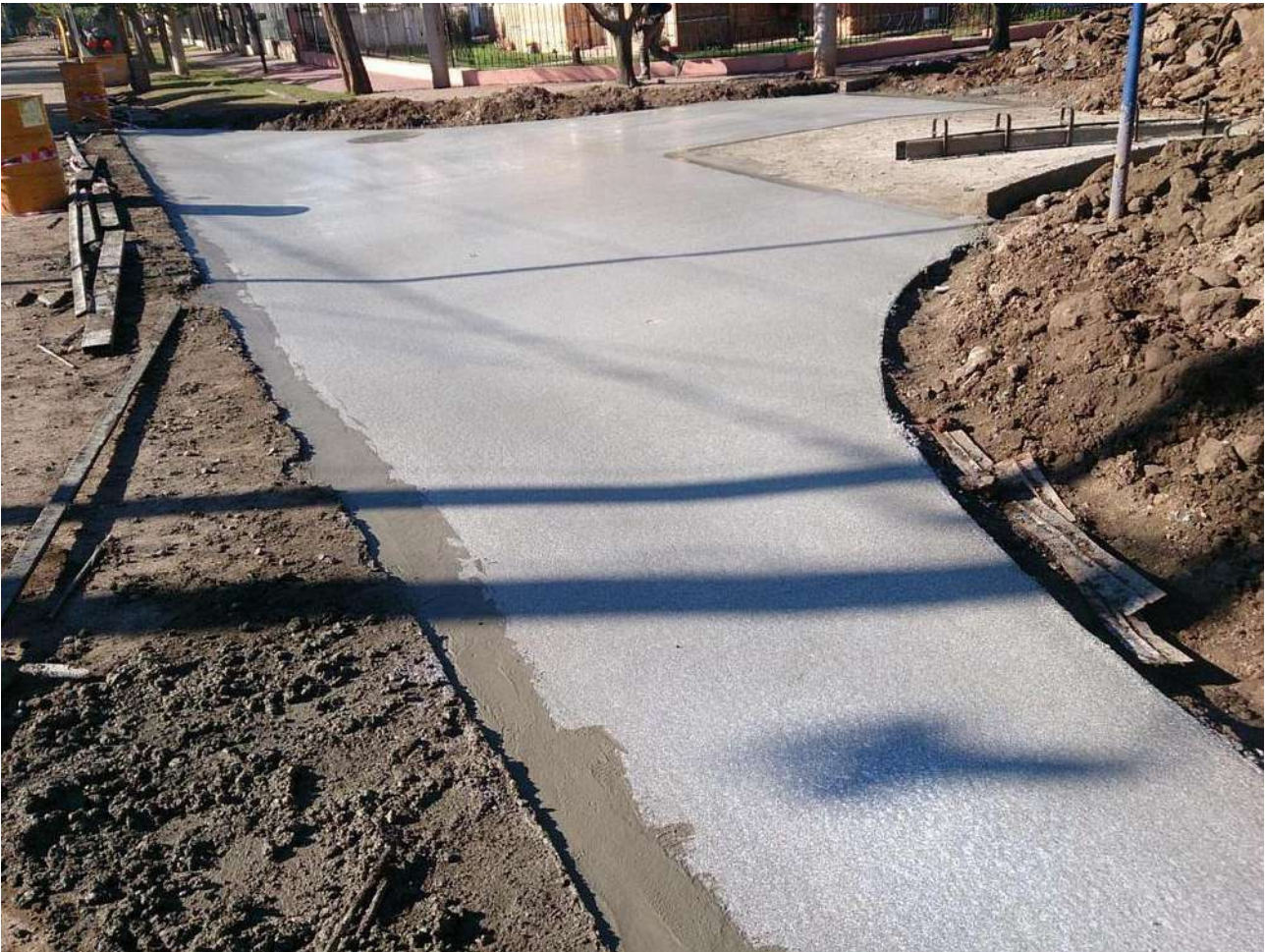
Figura 16 – Badén de hormigón.
