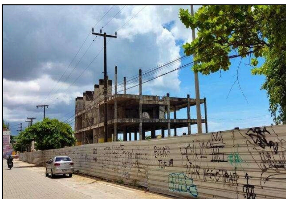
Figura 18 – Obra interrompida do Acquário de Fortaleza.
