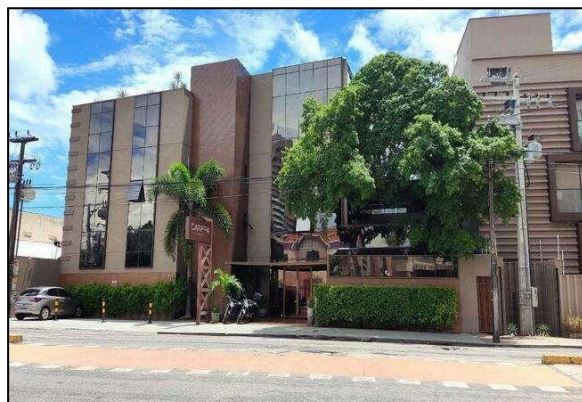
Figura 7 – Hotel Carppa localizado no bairro Praia de Iracema
