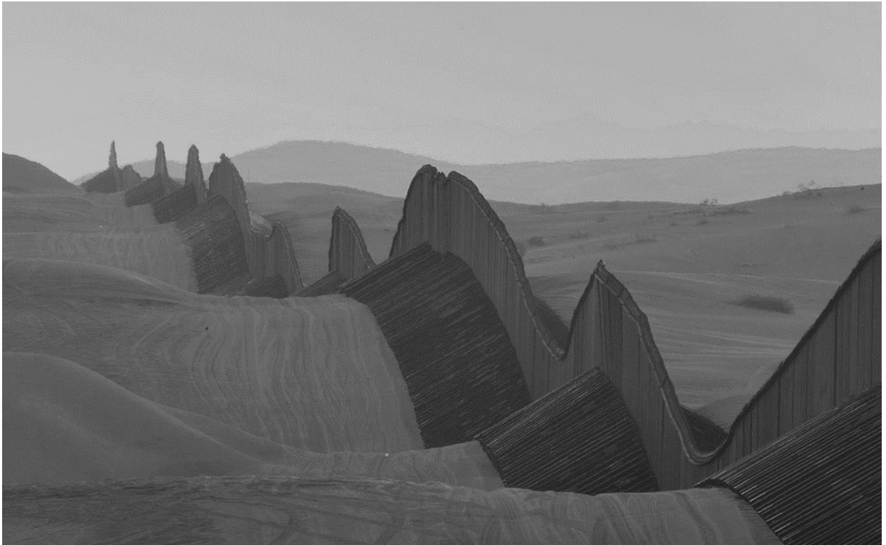
Figura 5 – O muro construído na fronteira dos EUA com o México, em pleno Deserto de Sonora. A estrutura foi erguida acima das dunas, para que possa ser levantada por uma espécie de guincho e "colocada no lugar devido" à medida em que a areia a cobre.
