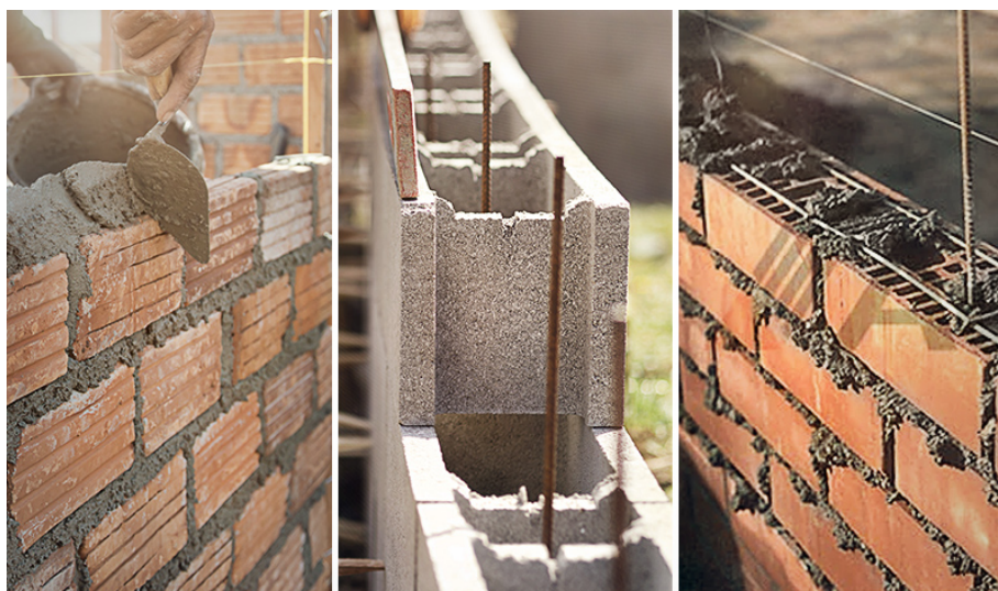
Figura 5: Muros de albañilería.
