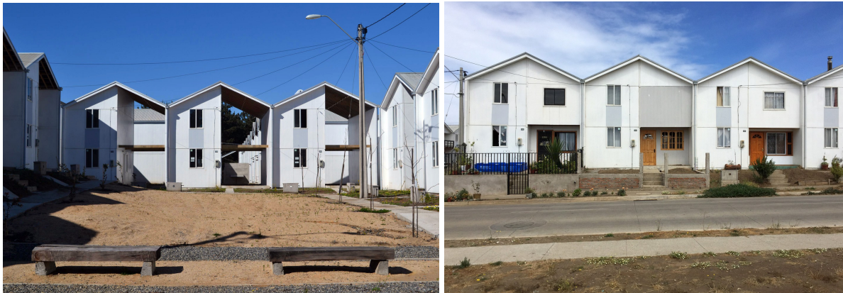
Figura 27: Viviendas Villa Verde subsidiadas por el Estado, creadas por Elemental, en Constitución, proyectadas en 2010.
