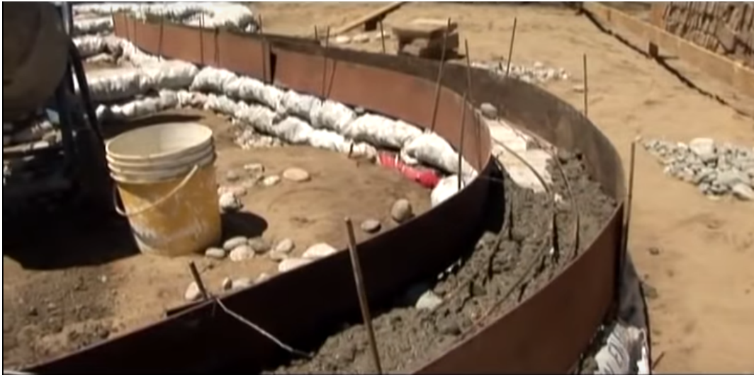
Figura 10: Muro de paredes de sacos de ripio.
