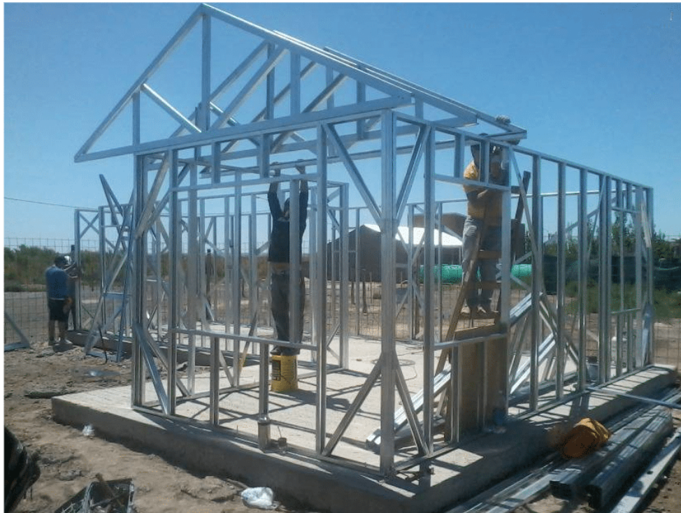
Figura 7: Estructura de acero.
