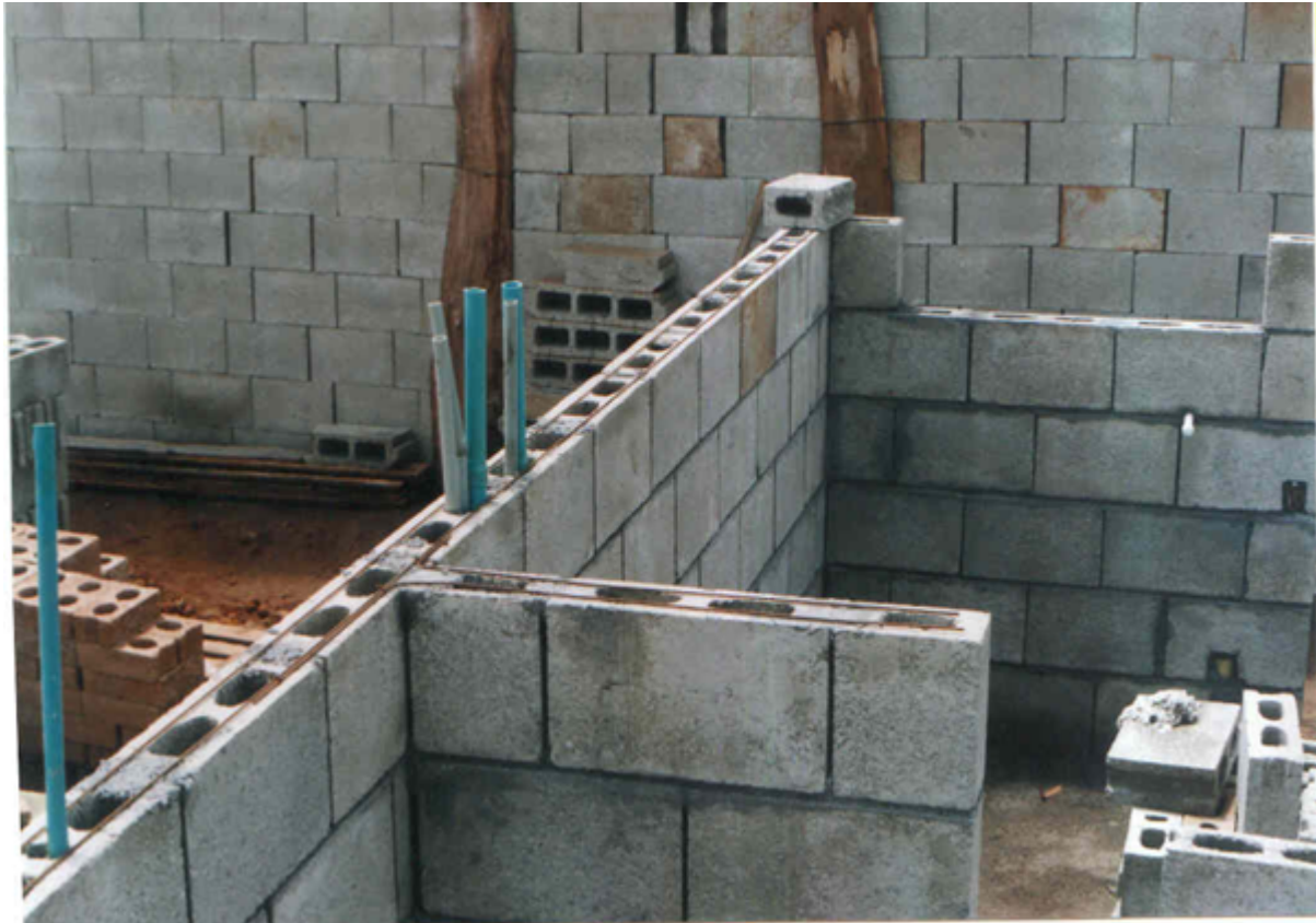
Figura 3: Muro estructural con bloques perforados de concreto.
