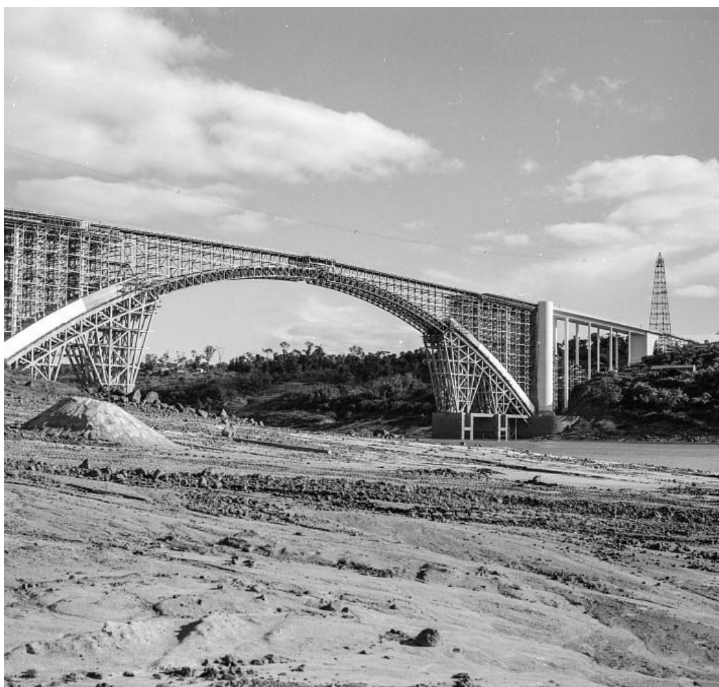
Fotografia 2 - Construção da Ponte da Amizade, Anos 60.
