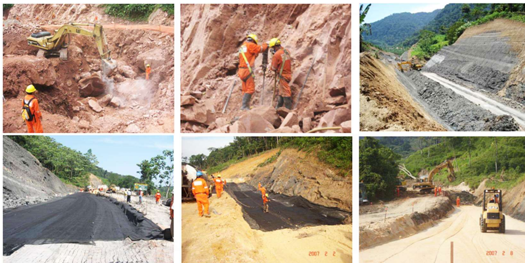
Figura 7 - Fotos do início da construção em 2007
