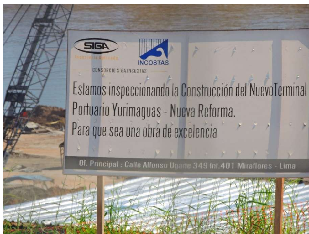
Figura 19 - Futuro porto em construção
