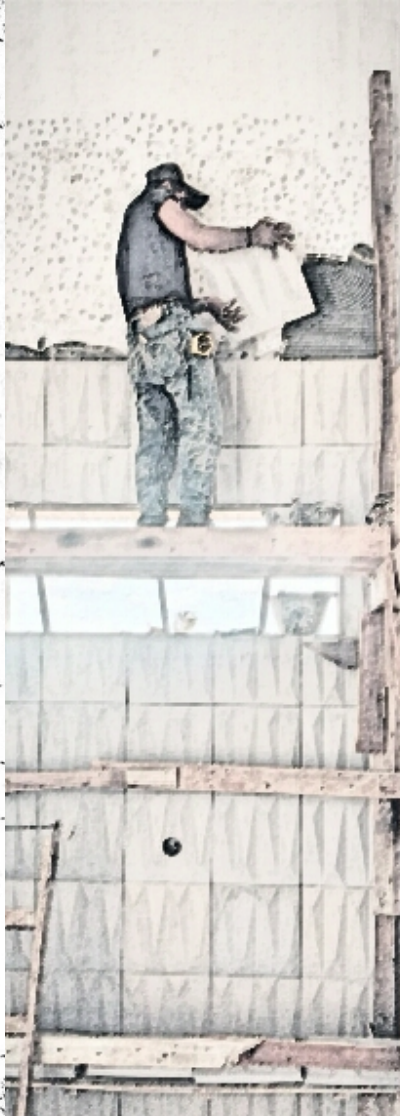
Albañil colocando revestimiento, 2022. Fuente: imagen cedida por el entrevistado. enero 2022
