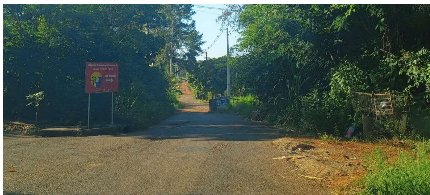
Figura 1 – Final da porção pavimentada da Rua Malva Rosa
