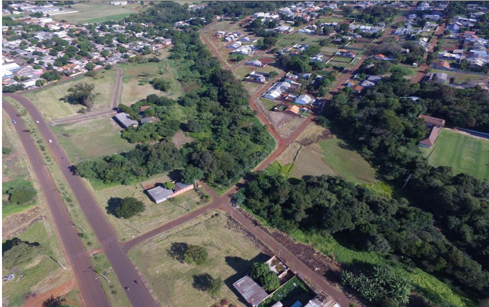
Figura 08: Zona de Confluência do rio M'Boicy com Rio Poti.
