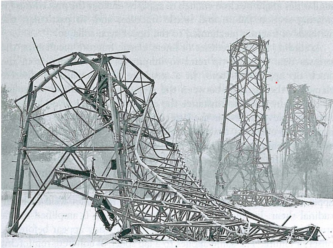
Figura 2.5 – Colapso tipo dominó de torres de transmissão de energia. (Alemanha, 2005).
