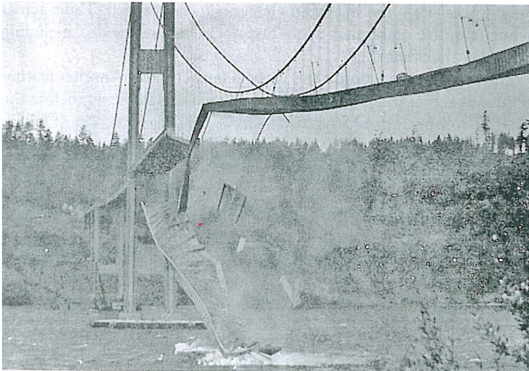
Figura 2.4 – Colapso tipo zíper na ponte Tacoma Narrows (Washington, 1940).
