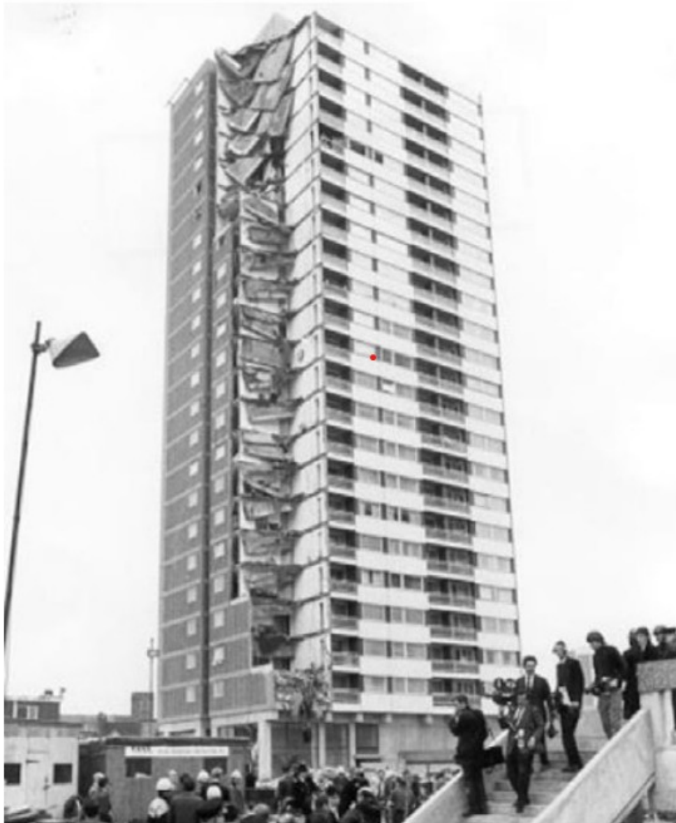
Figura 2.3 – Colapso parcial do edifício Ronan Point, (Londres, 1968).
