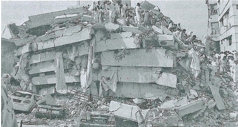
Figura 2.1 – Colapso tipo panqueca, provocado por um terremoto (Islamabad, 2005).
