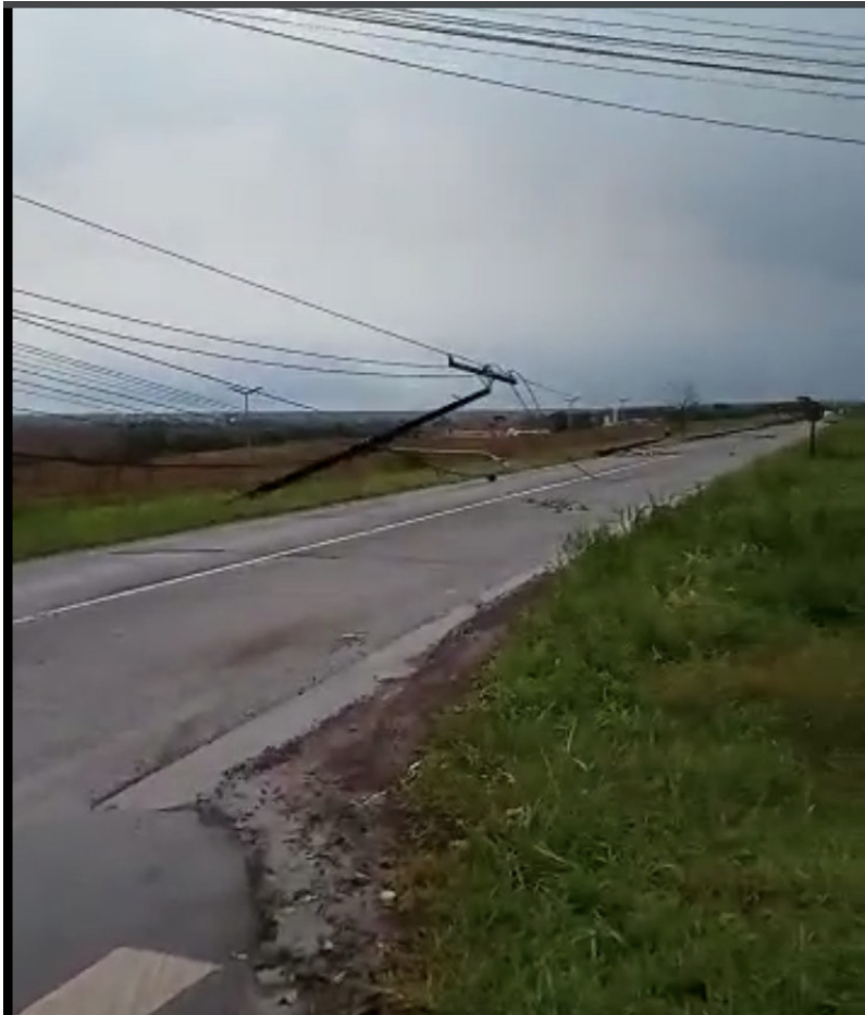
Figura 2.6 – Colapso tipo dominó de postes de energia (Foz Do Iguaçu, 2021).
