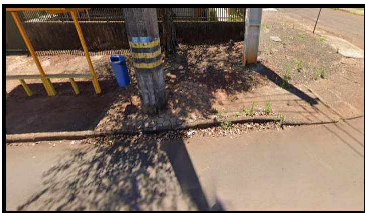
Figura 5 – Calçada de ponto de ônibus sem piso tátil e com obstáculos.
