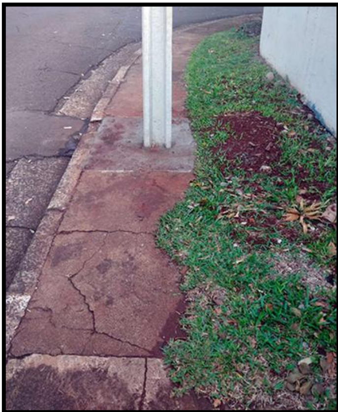
Figura 6 – Calçada sem acessibilidade.
