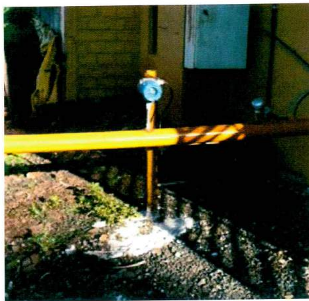
Figura 13 - Medidor de vazão em Colombari (ITAI, 2011)
