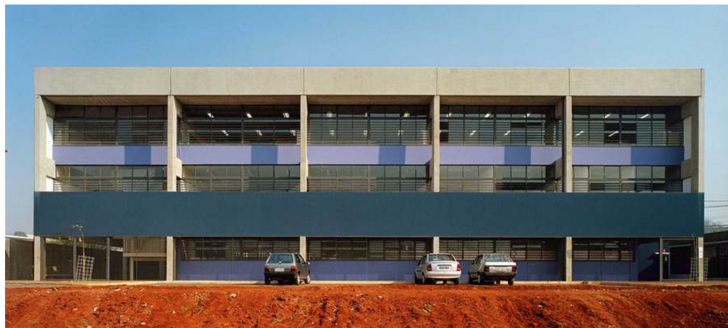
Imagem 47 - Fachada da escola.
