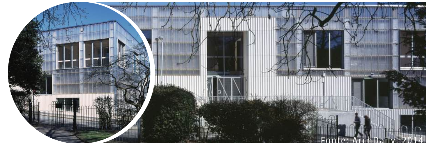
Imagem 21 e 22 - Fachada metálica do centro TNG.
