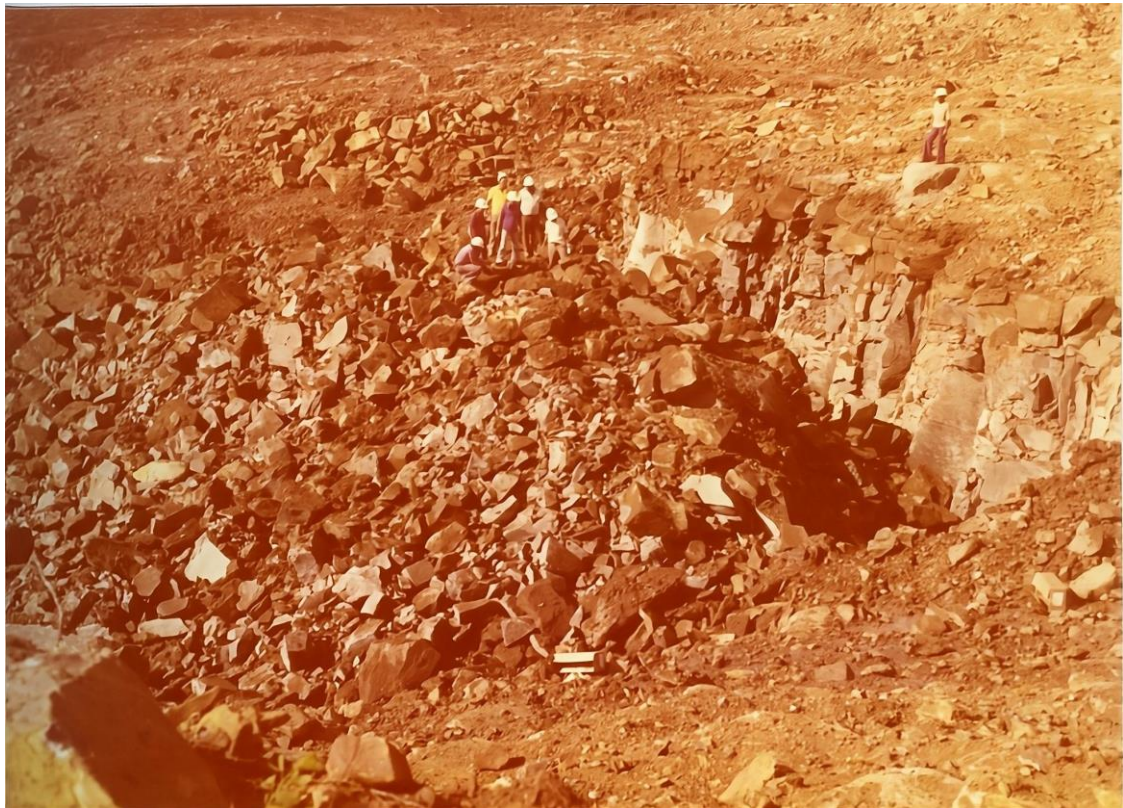
Figura 5: Fotografia 04 – Resultado da primeira explosão do canal de desvio, 1976
