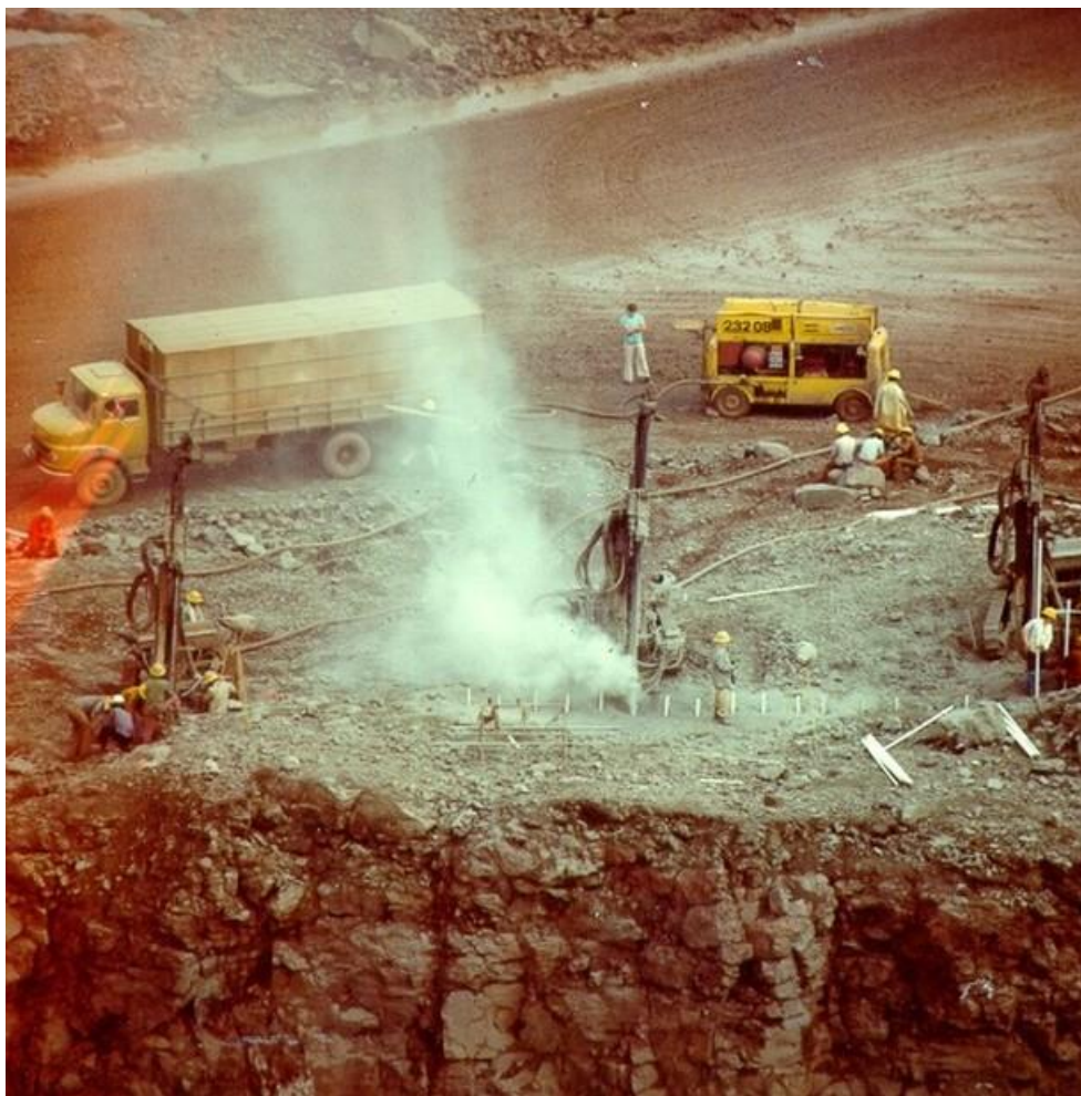
Figura 8: Fotografia 07 – Flagrante de trabalho das escavações em rocha, 1976
