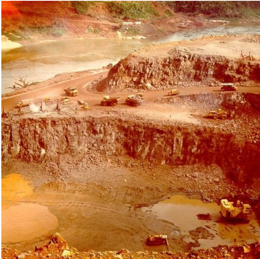
Figura 7: Fotografia 06 – Flagrante de trabalho das escavações em rocha, 1976
