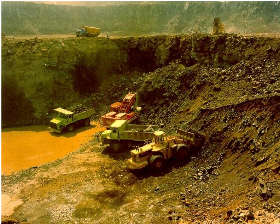
Figura 9: Fotografia 08 – Flagrante de trabalho das escavações em rocha, 1976
