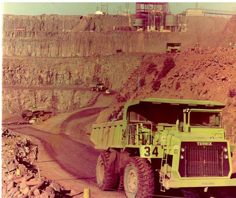
Figura 10: Fotografia 09 – Flagrante de trabalho das escavações em rocha, 1977
