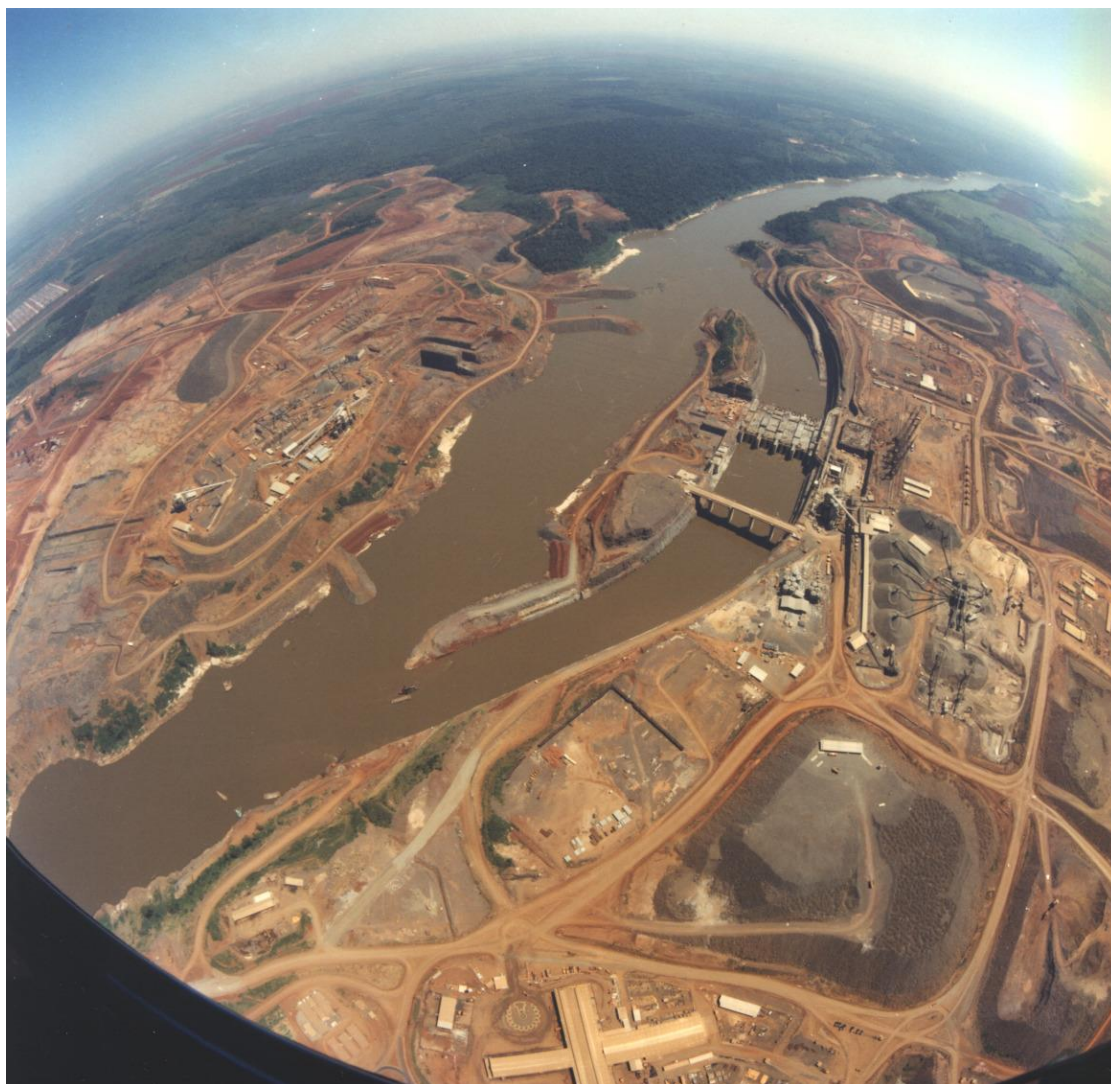
Figura 3: Fotografia 02 – O canal de desvio em outubro de 1978
