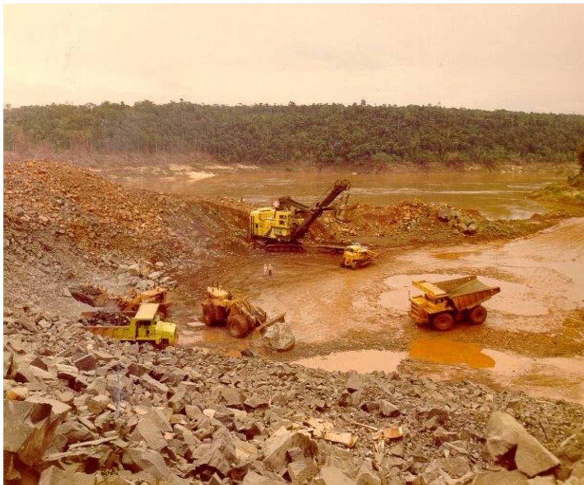
Figura 6: Fotografia 05 – Flagrante de trabalho das escavações em rocha, 1976
