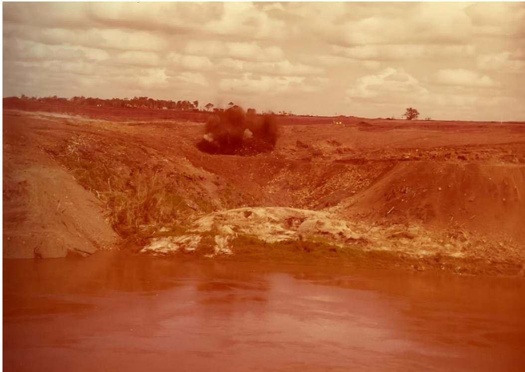
Figura 4: Fotografia 03 – A primeira explosão do canal de desvio, 1976
