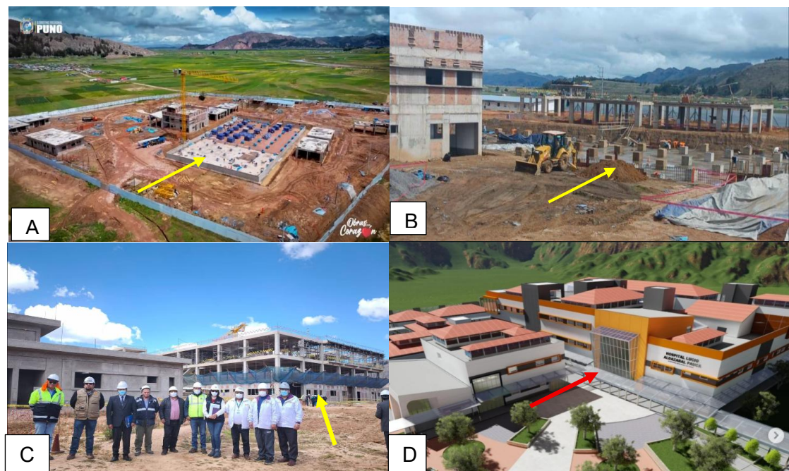
Figura 25 – Execução do Hospital a) ano 2023; b) ano 2023, c) junho de 2026, d) Projeto render
