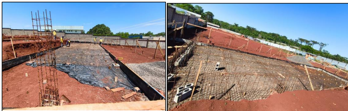
Figura 9 - Execução de fundação tipo radier
