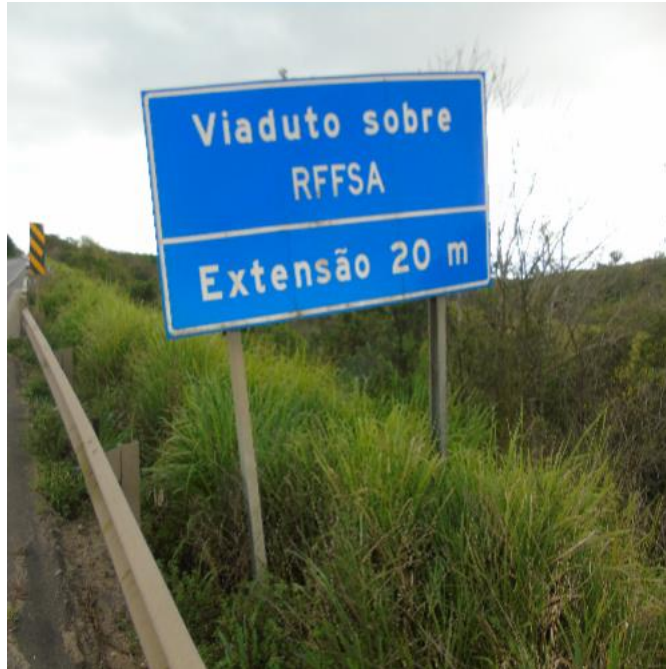
Figura 104 - Placa de identificação
