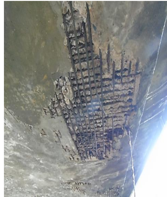
Figura 18 - Patologias apresentadas. (a) Pilar com mancha de fogo; (b) Laje com concreto desagregado, armaduras expostas e oxidadas, além de armaduras rompidas
