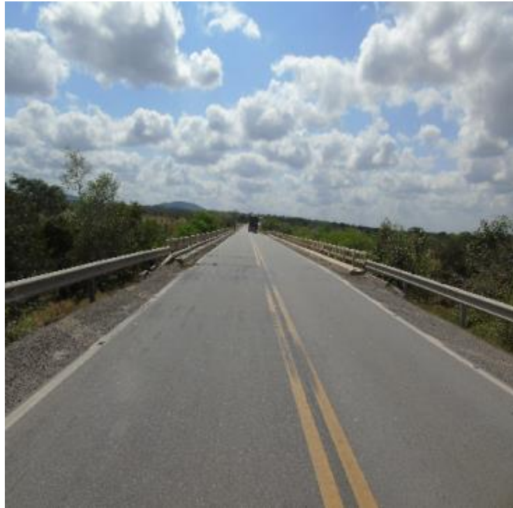
Figura 23 - Foto de identificação superior da OAE/Ausência de sinalização vertical
