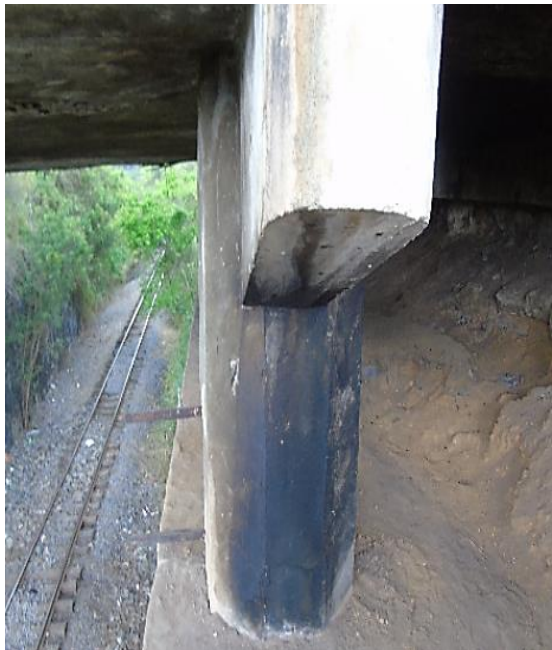
Figura 18 - Patologias apresentadas. (a) Pilar com mancha de fogo; (b) Laje com concreto desagregado, armaduras expostas e oxidadas, além de armaduras rompidas
