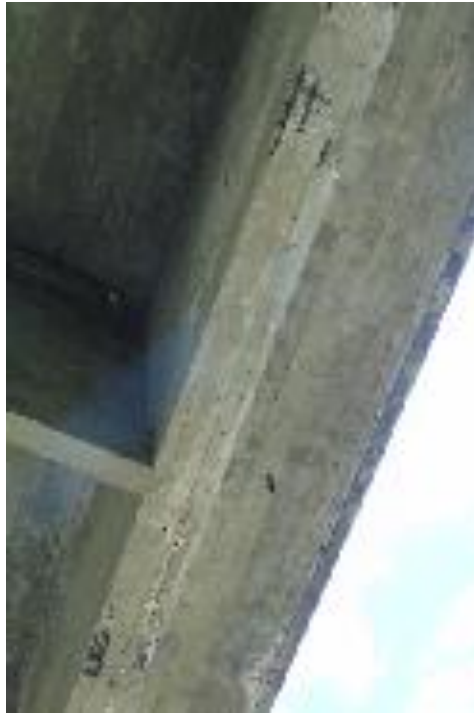
Figura 31 - Viga T ou I - Nicho de concretagem
