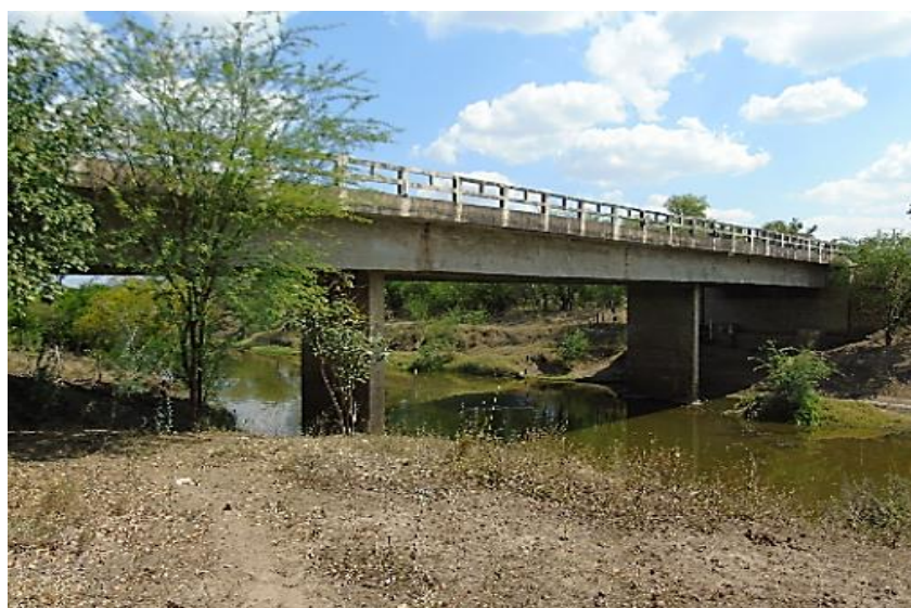
Figura 12 - Ponte sobre o Rio Capivari – Vista inferior lateral
