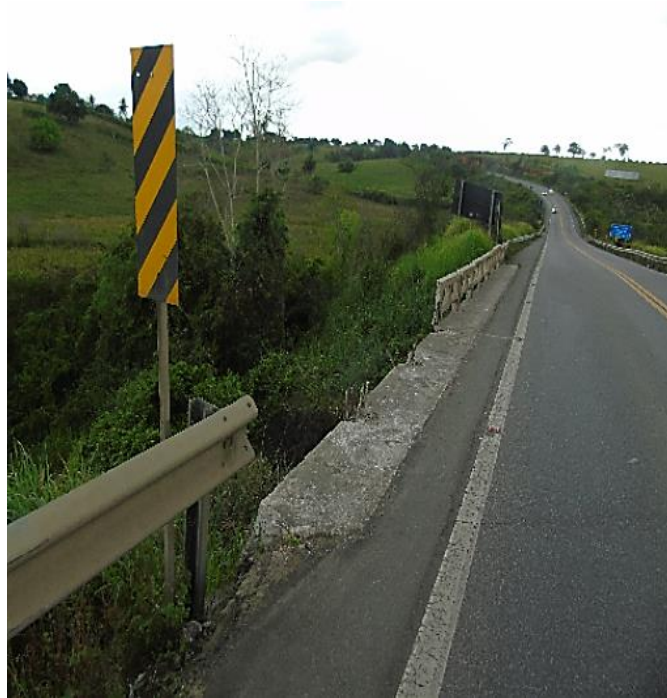
Figura 17 - Viaduto km 217,24 sobre Ferrovia – Vista superior
