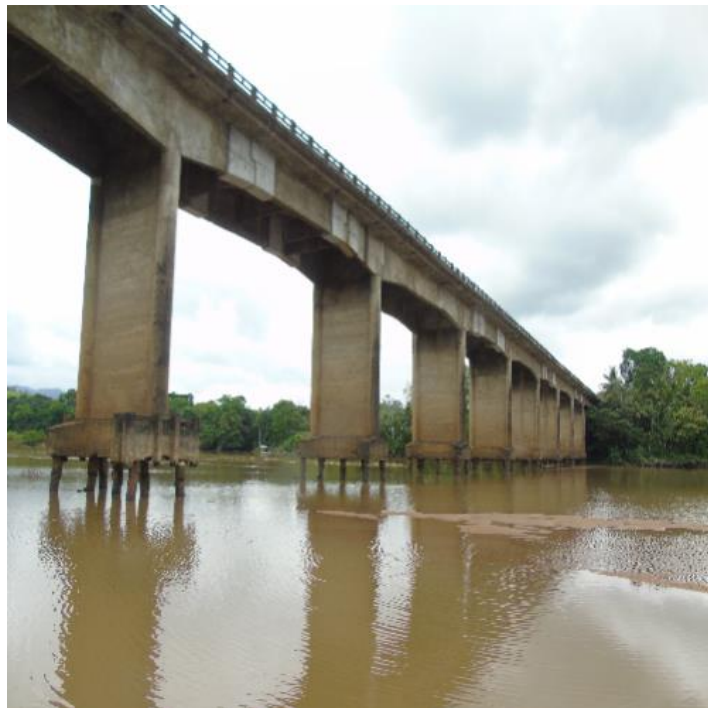
Figura 101 - Vista lateral da OAE
