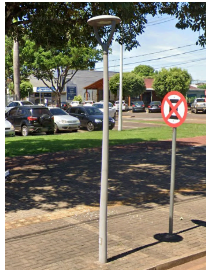
Figura 114: Poste de iluminação pública. Fonte: Google Maps, 2025.
