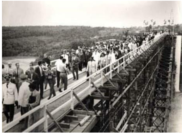
Figura 7: Ponte da Amizade em construção, 1961
