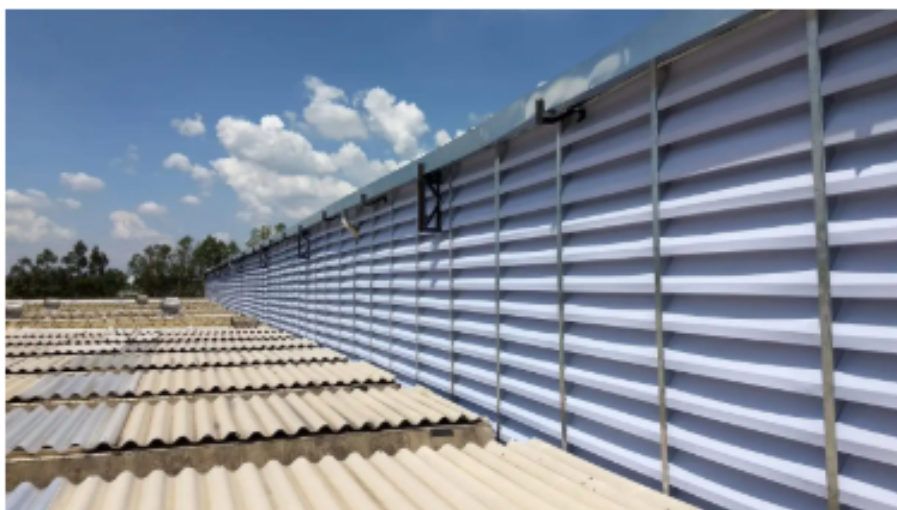
Figura 7 - Exemplo de lanternim com veneziana superior em indústria.
