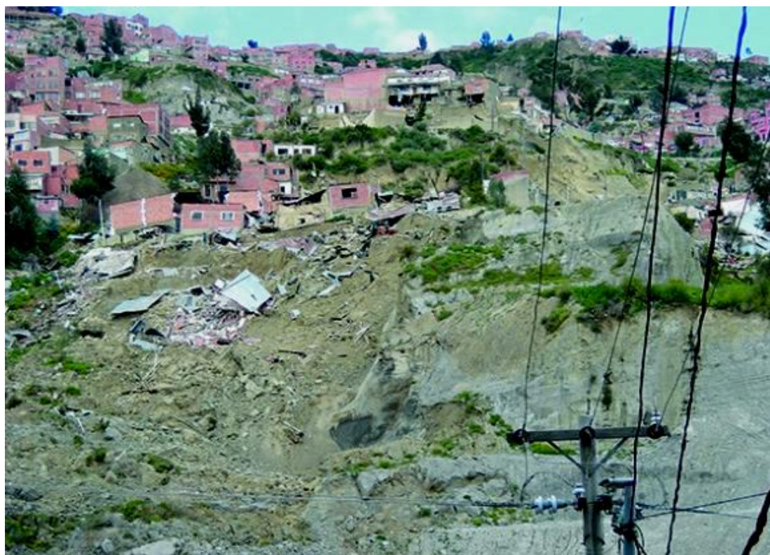
Figura 11 – Deslizamiento en Bajo Llojeta Fuente - GMLP
