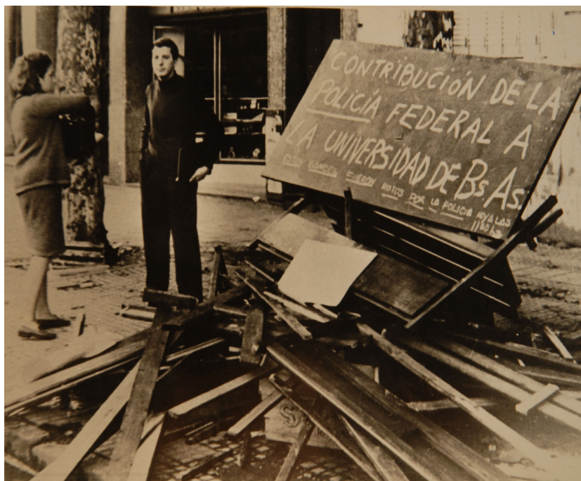
Foto 04: Os estragos causados pela intervenção policial. Fonte: EducAr .
