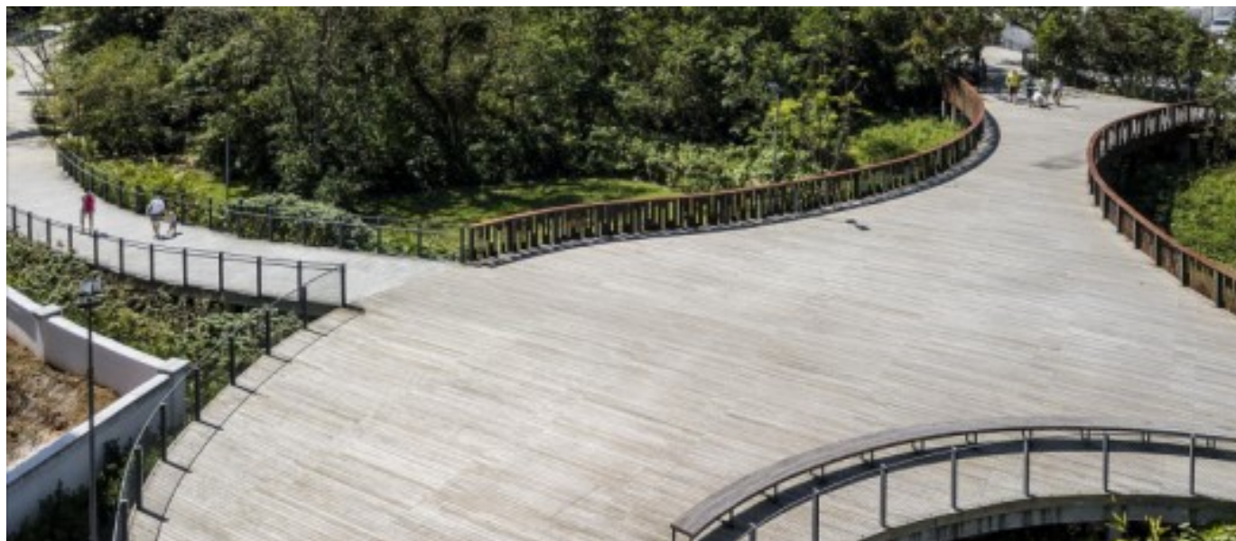
Figura 15 - Ponte praça. Fonte: ArchDaily. Disponível em: https://www.archdaily.com.br/br/991236/parque-linear-do-corrego-grande-ja8-arquiteturaviva?ad_medium=gallery
