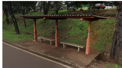
Figura 75 – Ponto Av. Tancredo Neves. Fonte: Google Maps, 2022.
