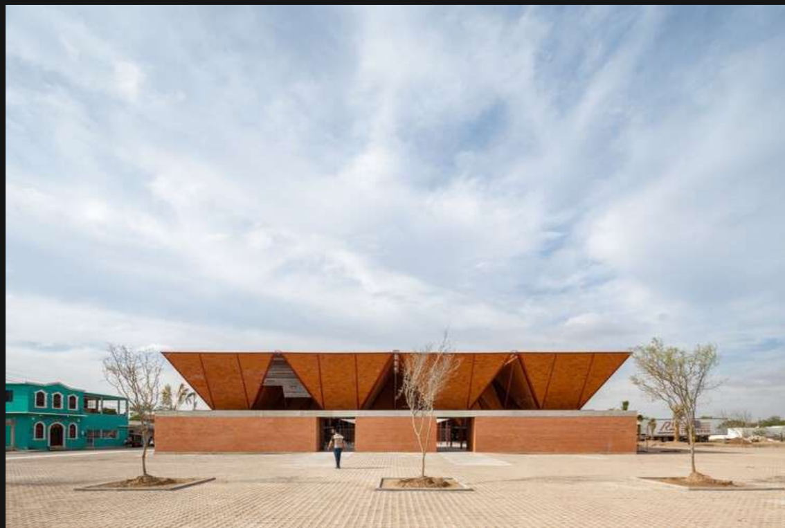
Figura 17: Fachada principal mercado Matamoros.
