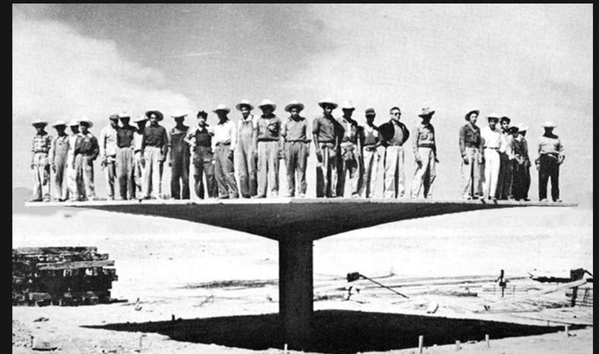
Figura 38: Prueba de carga en estructura del arquitecto Félix Candela
