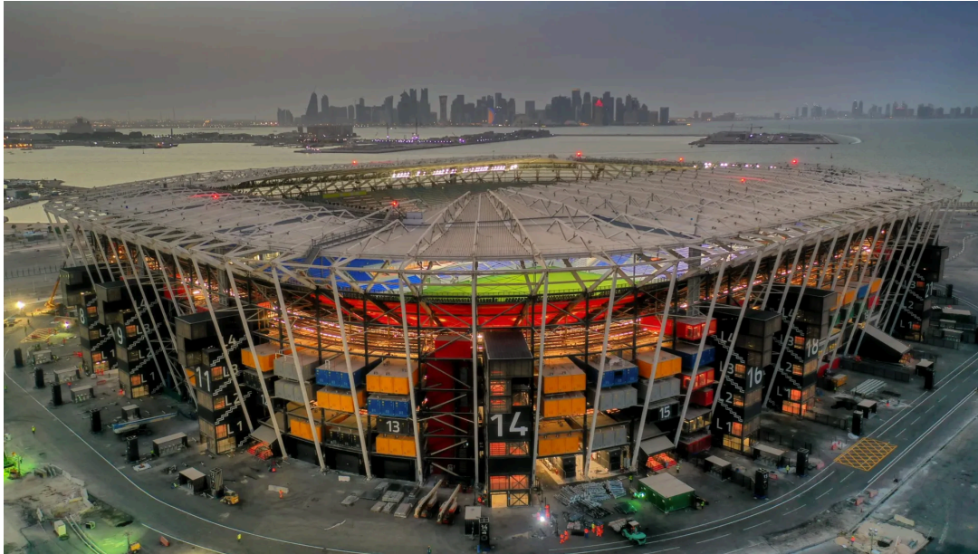
Figura 5 - Estadio construido a base de contenedores de carga reciclados
