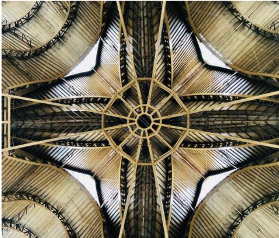
Figura 25 - Núcleo estructural de la nave central
