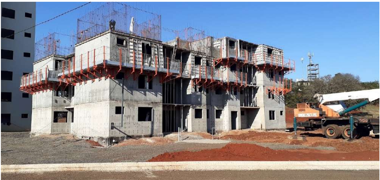
Figura 12 - Execução de uma das edificações em parede de concreto.
