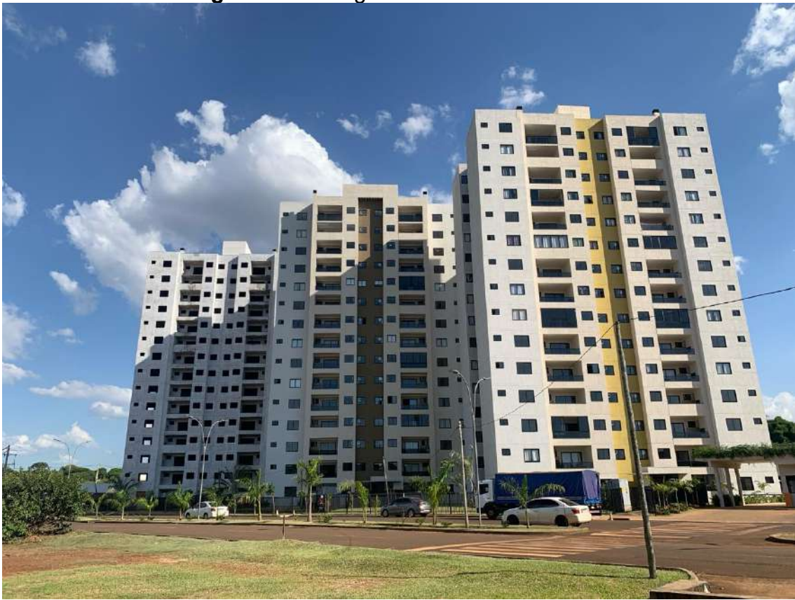
Figura 11 - Fotografia atualizada da obra.
