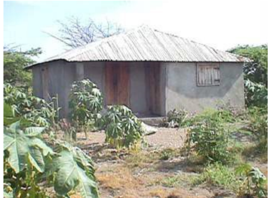
Casa rural de alvenaria com cobertura de zinco
