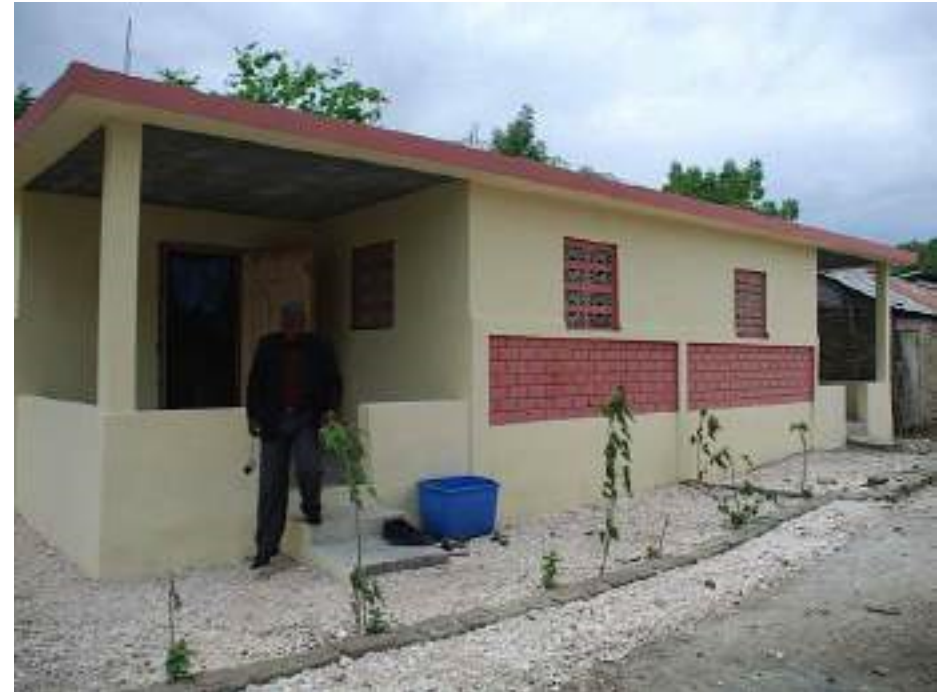
Casa popular haitiano de Alvenaria com Laje de concreto
