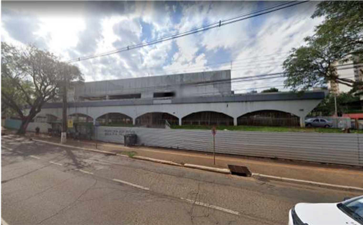
FIGURA 2: Edifício escolhido para a inserção do ensaio projetivo.
