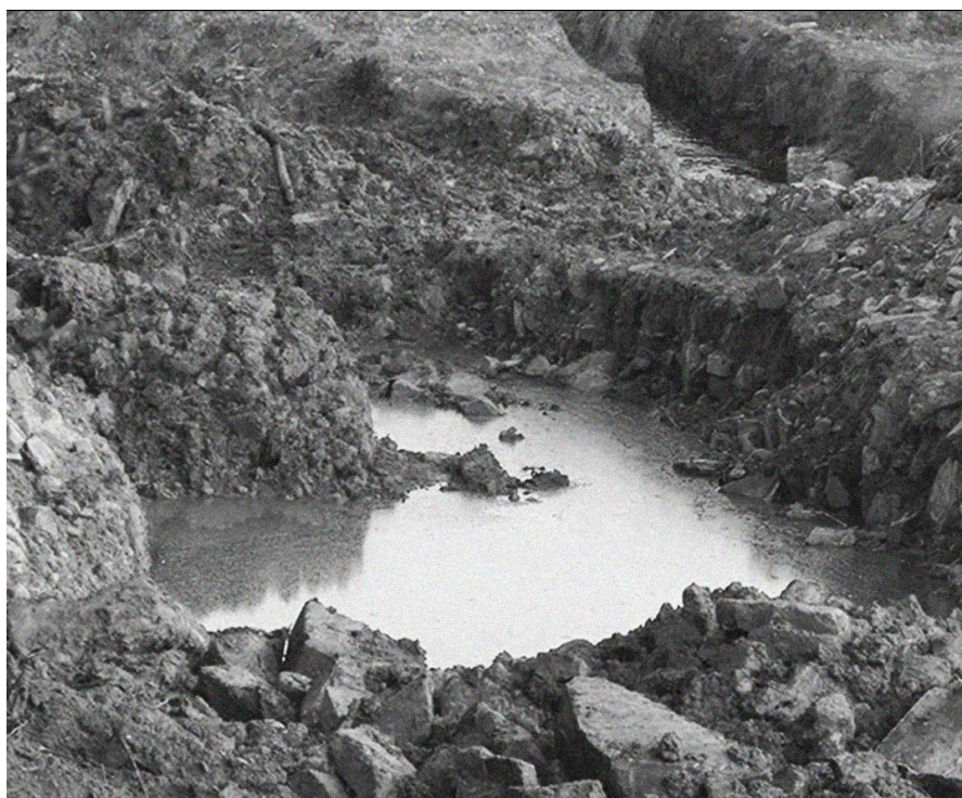
Figura 89: Paisagem da obra da Perimetral, Foto: Manuel Corman, 2023.
