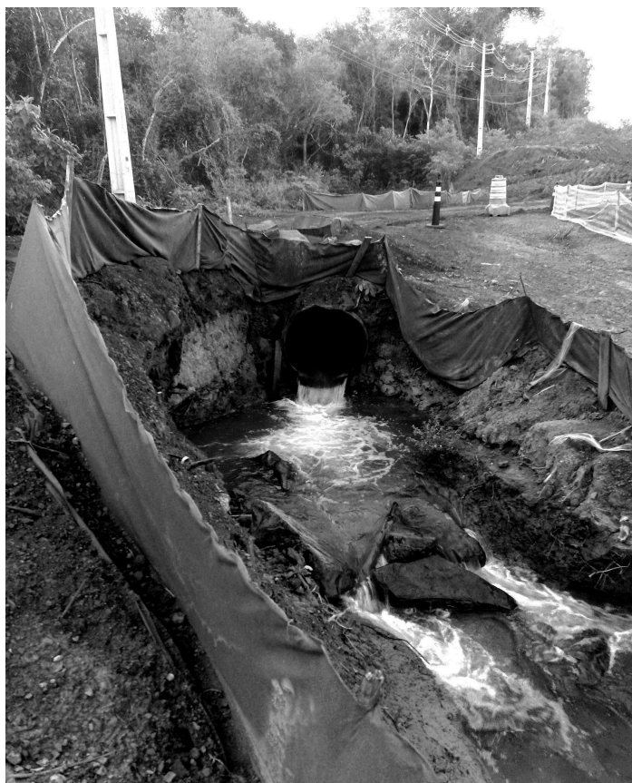
Figura 92: Cenário da obra da Perimetral, Foto: Manuel Corman, 2023.
