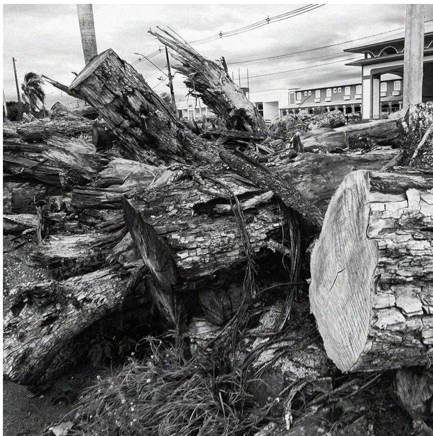
Figura 88: Troncos deitado na obra da quadruplicação da Avenida Cataratas, Foto: Manuel Corman, 2023.
