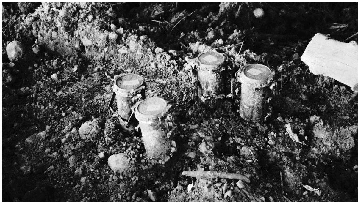
Figura 86: Mostra concreto, obra da Perimetral, Foto: Manuel Corman, 2023.
