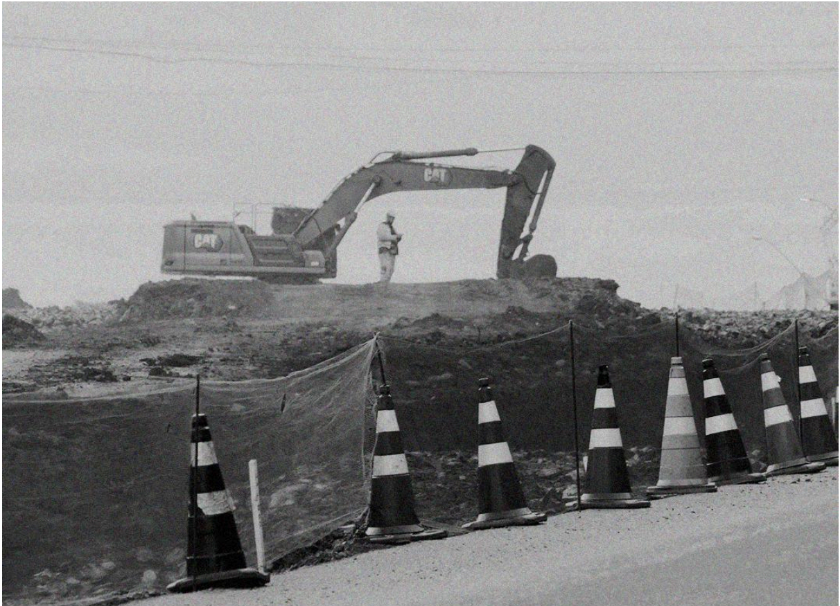
Figura 90: Obra de quadruplicação da Avenida Cataratas, Foto: Manuel Corman, 2023.
