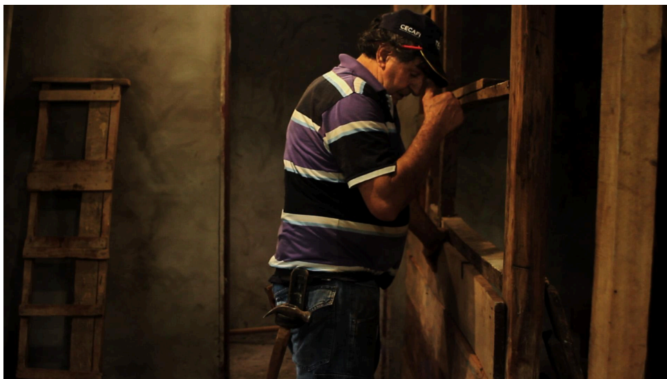
Figura 34: Luiz fazendo a parede entre o quarto e o banheiro, Foto: Manuel Corman, 2021.
