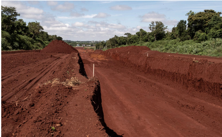
Figura 58: Obra da perimetral atrás de casa, foto: Manuel Corman, fevereiro 2024.
