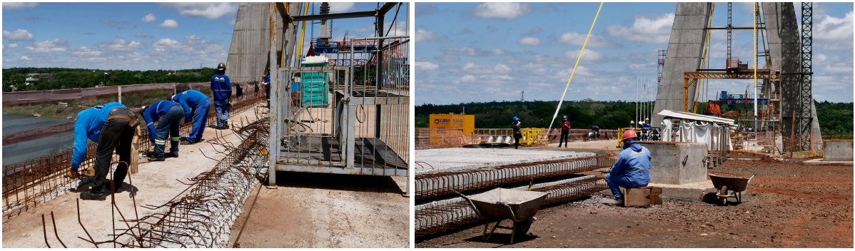
Figura 46: Construção da Ponte da Integração, Fotos: Manuel Corman, Outubro, 2021.
