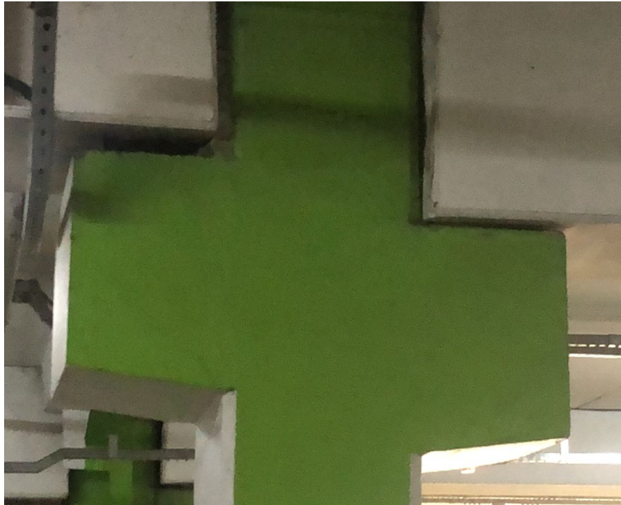
Figura 1 – Ligação viga-pilar
