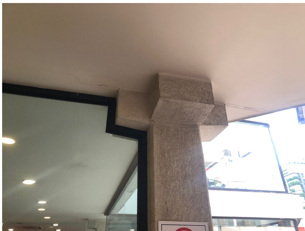
Figura 3 – Consolos projetados em faces diferentes de um pilar
