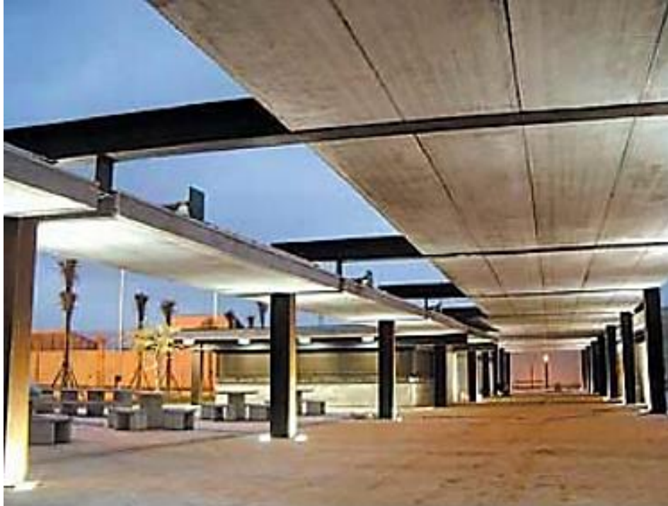
Figura 56: Marquesina con quioscos y servicios higiénicos
