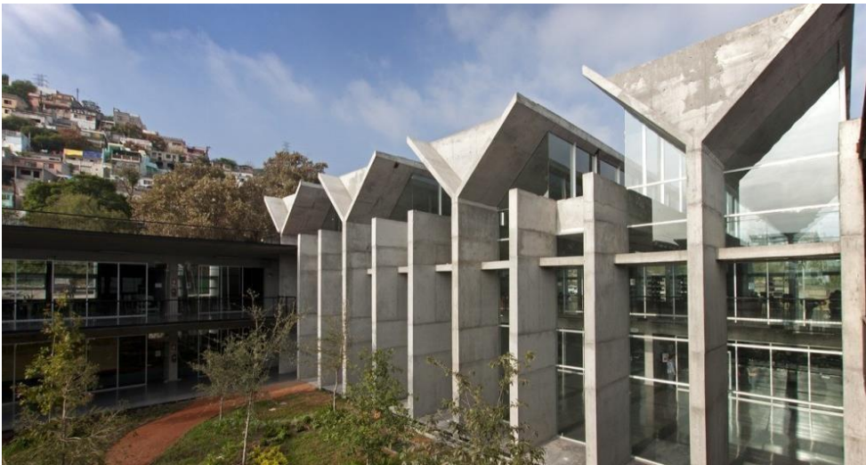
Figura 50 – Vista desde el patio interno
