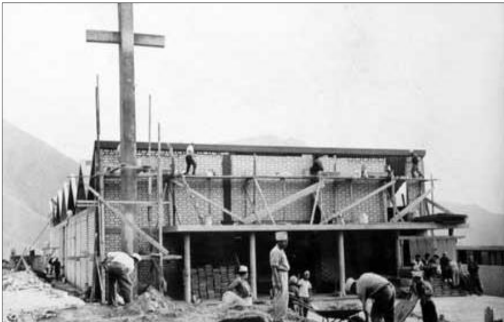
Figura 16: Construcción de Iglesia
