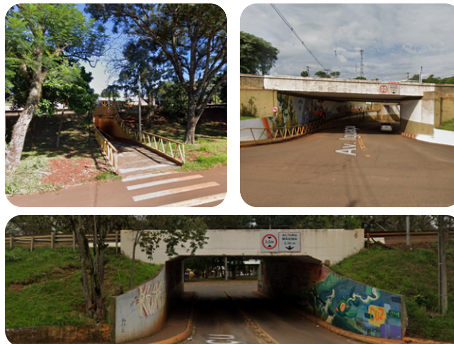
Figura 26 - Túneis de acesso sob a BR 277
