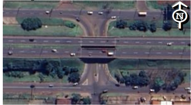
Figura 3.3.1.3 – Paso a desnivel km 5,5
