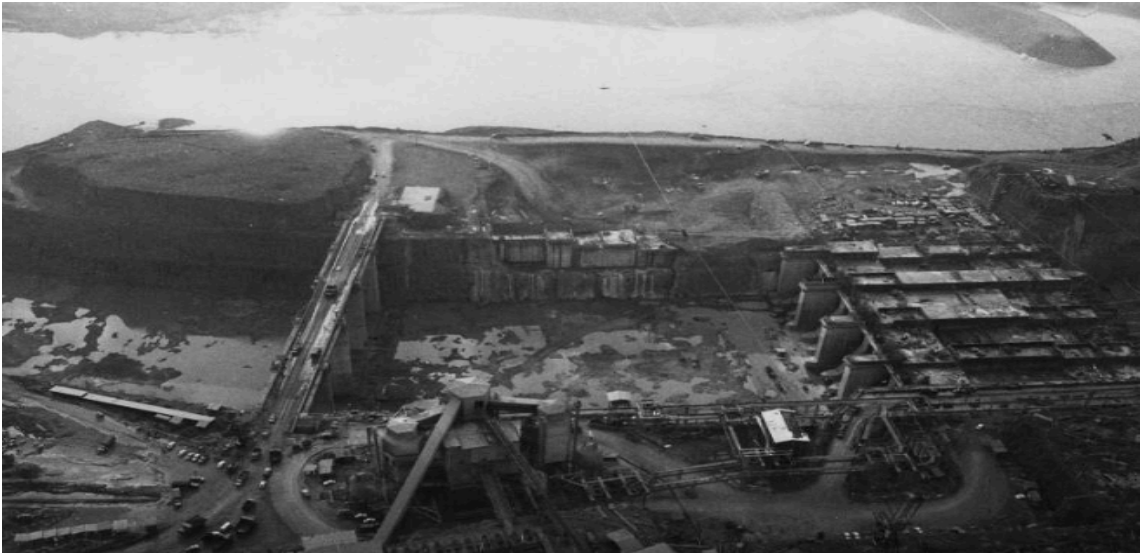
Figura 7: Construção da Usina Hidrelétrica de Itaipu - 1978
