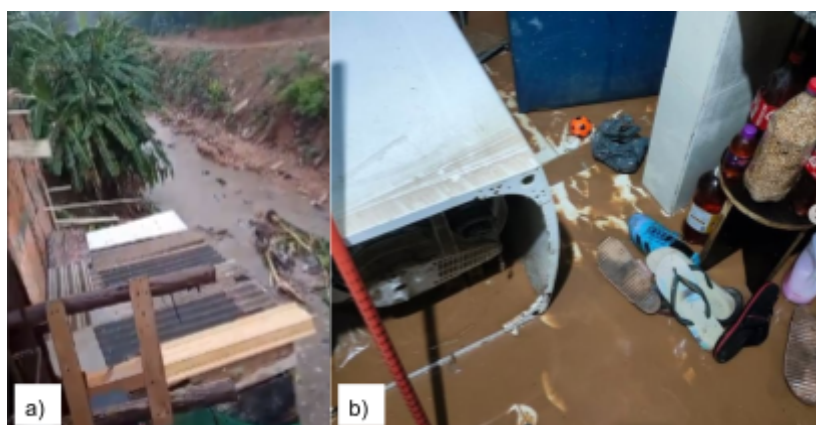
Figura 3 - Danos causados pela precipitação intensa: (a) residências na região ribeirinha; (b) situação da residência após o evento
