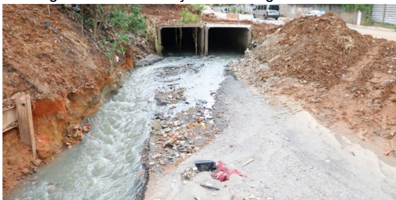
Figura 25 - Canalização do córrego do Cadaval
