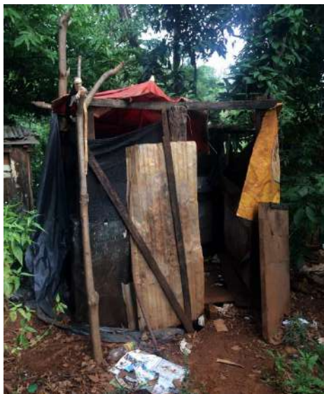
Imagem 46: Banheiro utilizado para defecar.
