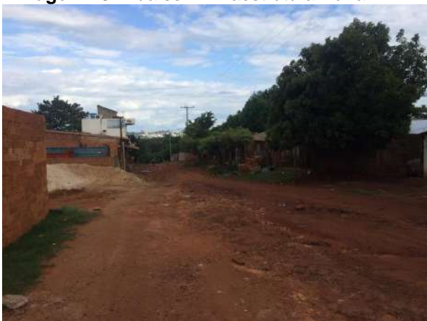
Imagem 25: Rua sem infraestrutura viária.
