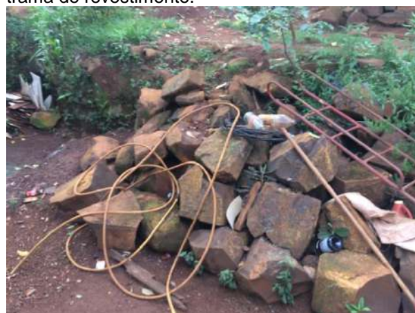
Imagem 34: Rochas retiradas de onde iria ser implantada a fossa séptica, e ao mesmo tempo foram utilizadas pra colocar dentro como uma trama de revestimento.
