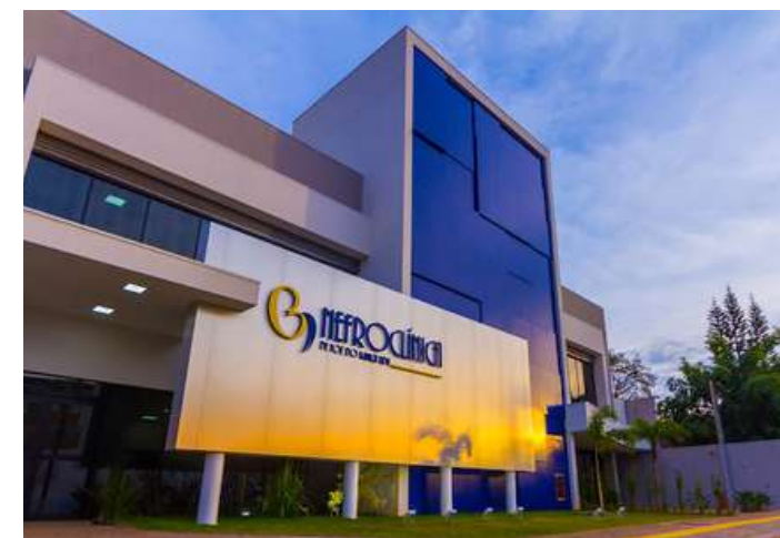
Imagem 58: Fachada Nefroclínica Fonte de dados: Nefroclínica, s/d.
