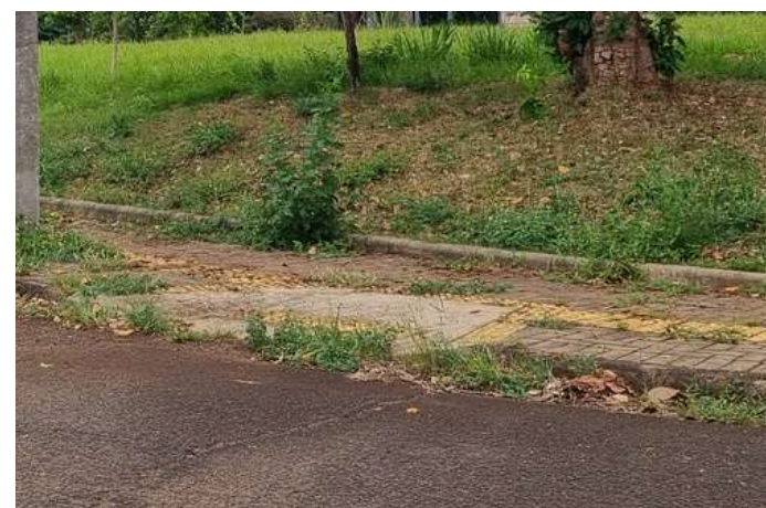
Imagem 74: Uma das rampas no entorno no terreno. Fonte: Elaboração autoral, 2024.
