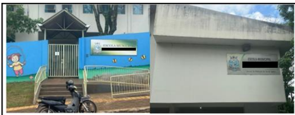
Imagem 5: Fachada atual da escola
