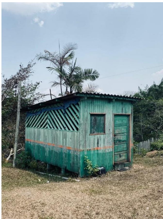
Fotografia 11 - Estrutura construída para proteger o gerador.
