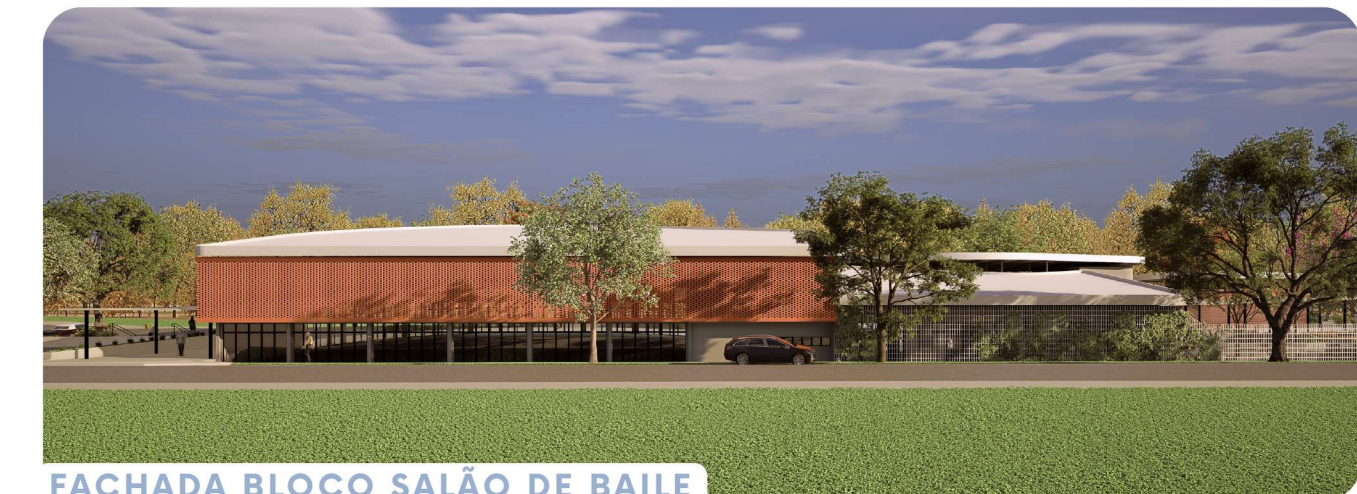
FACHADA BLOCO SALÃO DE BAILE
