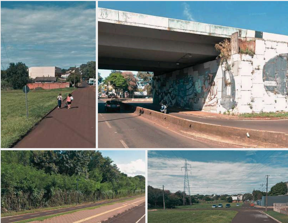
Figura 34: Composição ilustrando desafios da forma urbana no município, sob a ótica do pedestre: vazios, viadutos e intersecções de eixos viários, extensas áreas verdes e linhões de energia. Fonte: Google StreetView, 2024.
