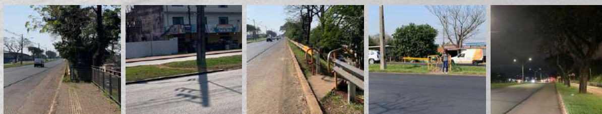
Figura 76: Situações encontradas no trecho: interrupção da calçada no trecho, demanda de travessia sem passagem pelo canteiro ou sinalização, acesso por escada sem segurança da calçada, ausência de faixa de pedestres na travessia e iluminação do trecho. Fonte: a autora, 2024.
