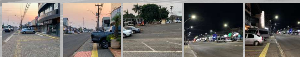
Figura 64: Situações encontradas no trecho: inconsistência da faixa livre da calçada, carro atrapalhando acessibilidade, cruzamento sem travessia de pedestres, poucos estabelecimentos de uso noturno e iluminação do trecho. Fonte: a autora, 2024.
