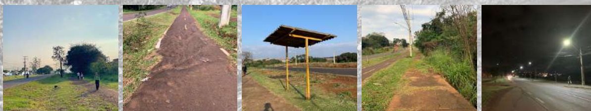
Figura 52: Situações encontradas no trecho: falta de pavimentação, ciclovia irregular aumentando risco de acidentes, ponto de ônibus sem assento, calçada com risco de desabamento no rio e iluminação do trecho. Fonte: a autora, 2024.
