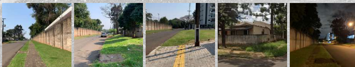
Figura 70: Situações encontradas no trecho: calçada ao lado de extensa área murada, segmento sem pavimentação, fragmentação da calçada, travessia sem faixa ou manutenção e iluminação do trecho. Fonte: a autora, 2024.
