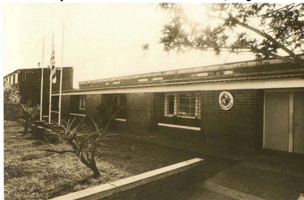
Figura 11 - Escola construída pelo sistema de cooperativas em um dos conjuntos habitacionais em Montevideu, Uruguai
