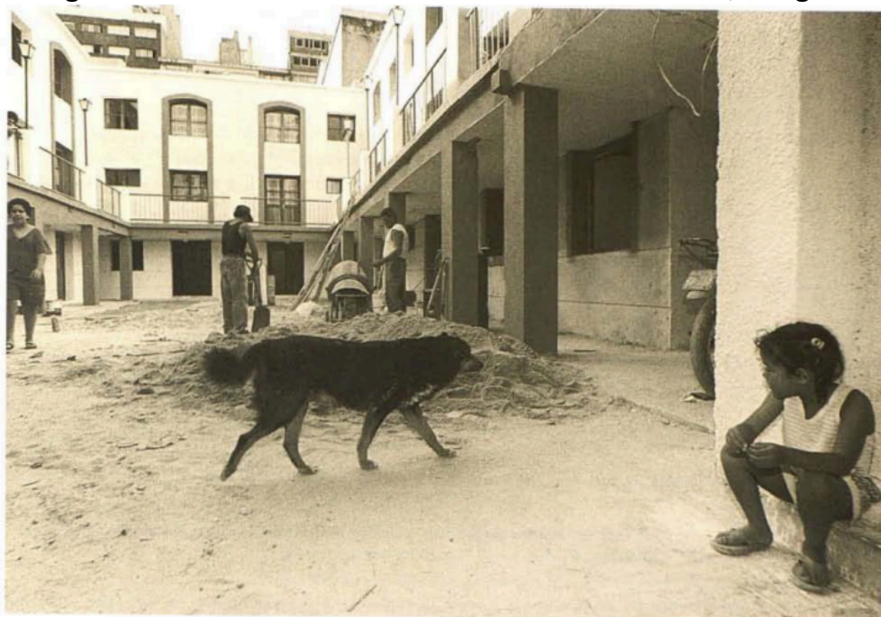
Figura 12 - Reforma de um edifício em Montevideu, Uruguai
