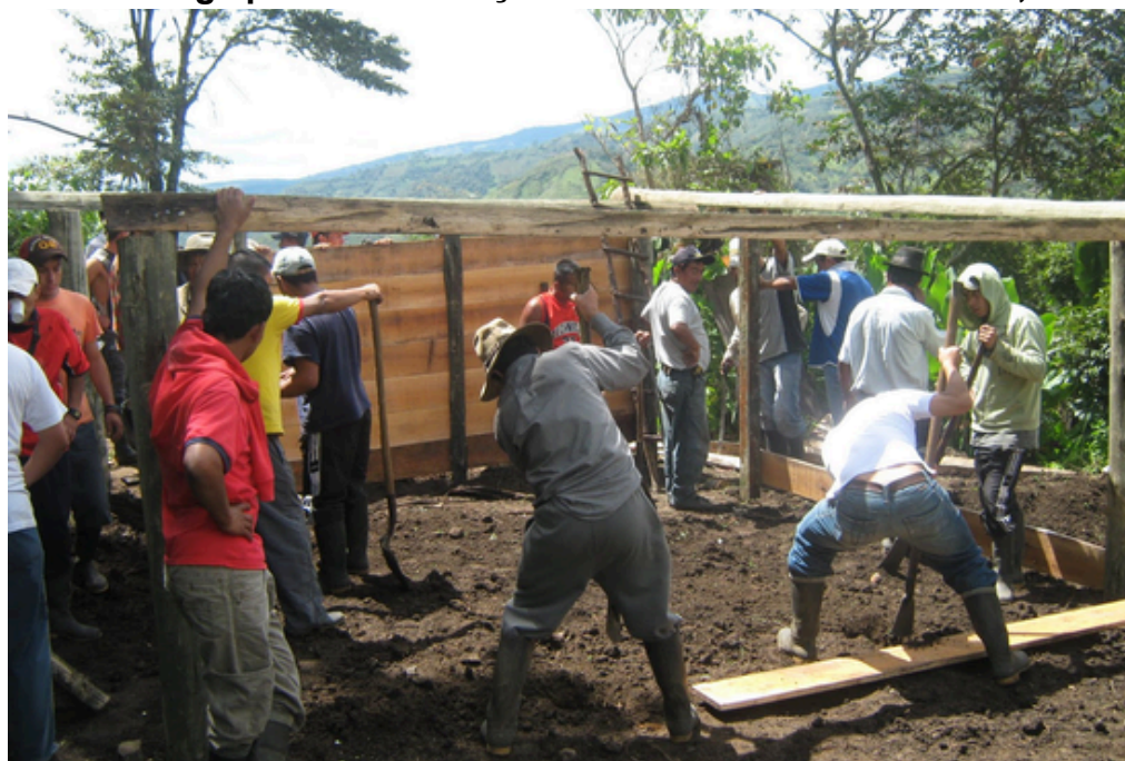
Figura 35 - Minga para a construção de uma casa em Santacruz, Colômbia
