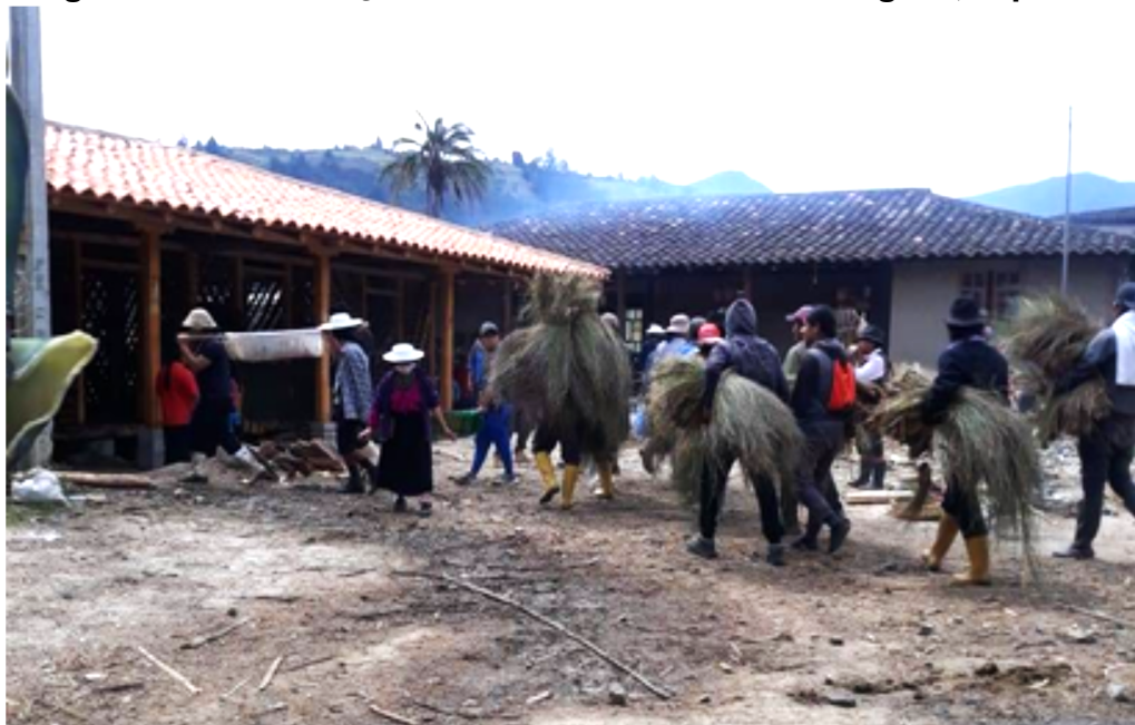
Figura 34 - Construção da Casa Comunal em Saraguro, Equador
